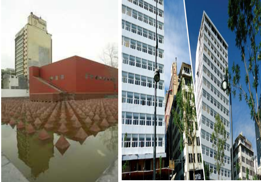
Cuadro 3. Hotel Bamer ciudad de México, antes y después.
