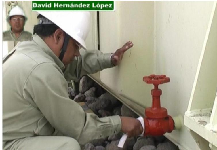
Figura 7.1. Limpieza de la válvula principal.
