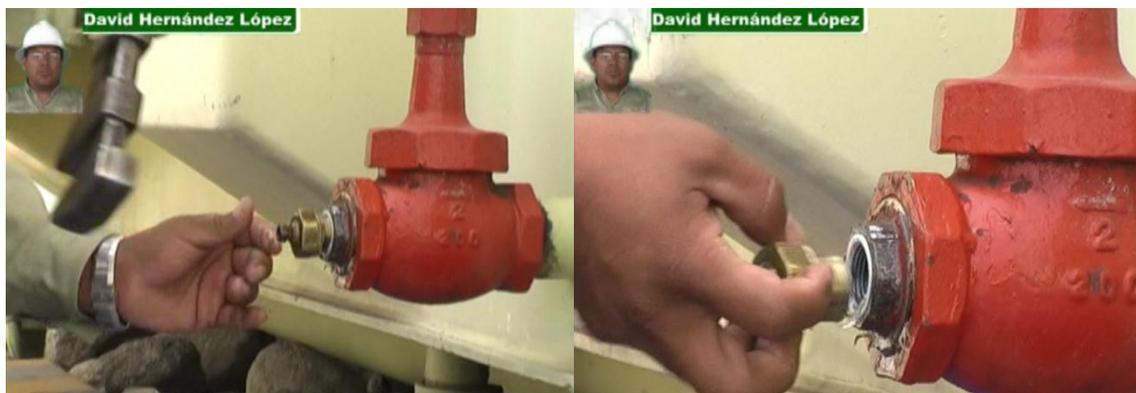
Figura 7.2. Retirar tapón de la válvula principal.
