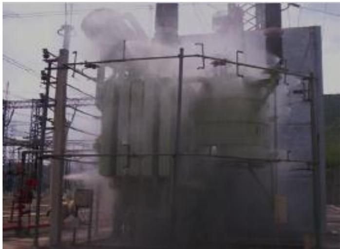
Figura 4.4. Sistema contra incendio en transformadores de potencia.
