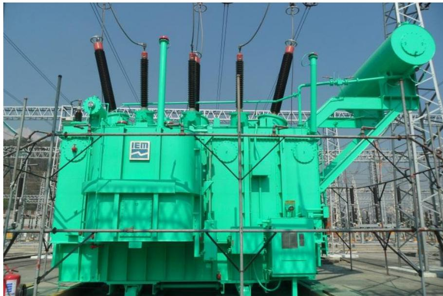
Figura 1.3. Transformador de potencia.
