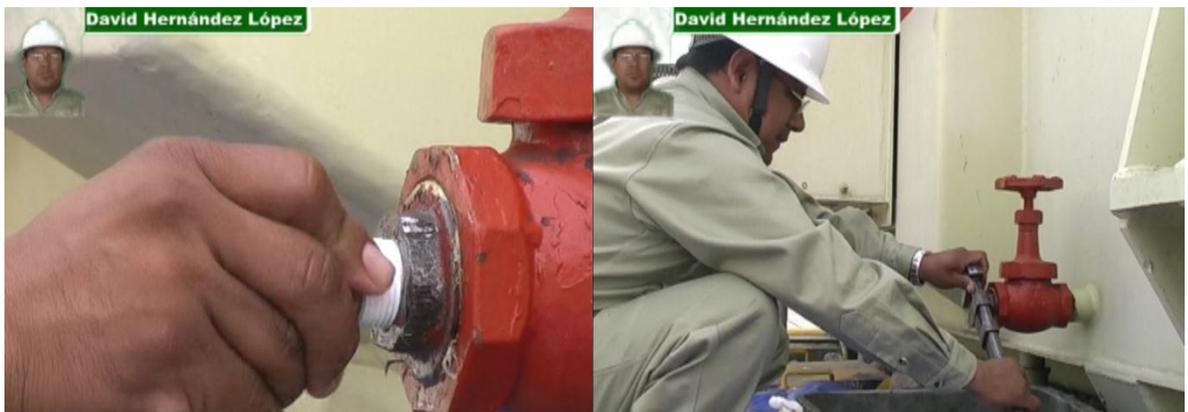
Figura 7.8. Cierre de válvula principal del transformador.
