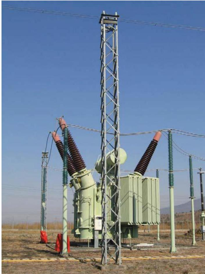
Figura 1.4. Reactor de potencia.
