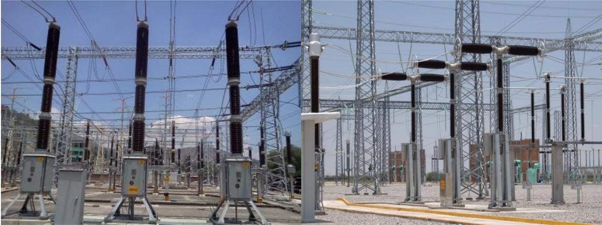
Figura 1.7. Interruptor de potencia monopolar.
