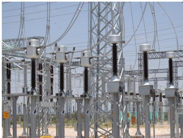
Figura 1.10. Transformador de Corriente.
