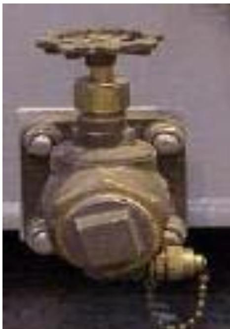
Figura 2.17. Válvula de drenaje.
