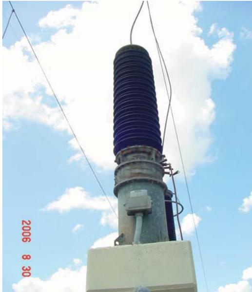
Figura 1.9. Transformador de potencial.
