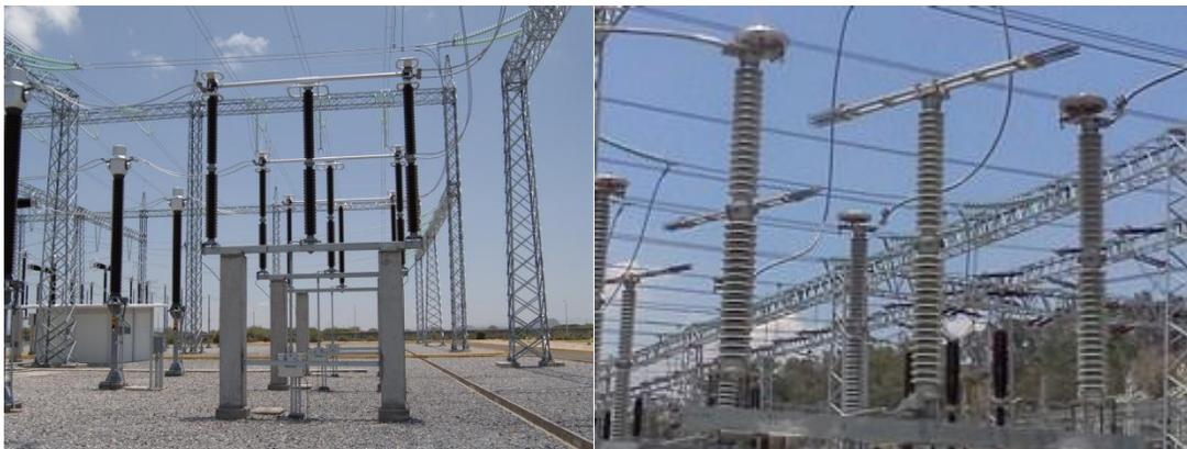
Figura 1.12. Cuchillas desconectoras.
