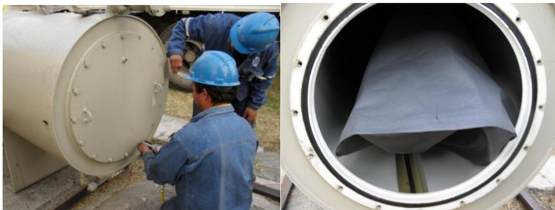
Figura 2.15. Con sello a través de una membrana o bolsa elástica.
