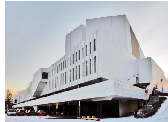
Centro Cultural de Alvar Aalto en Helsinki
