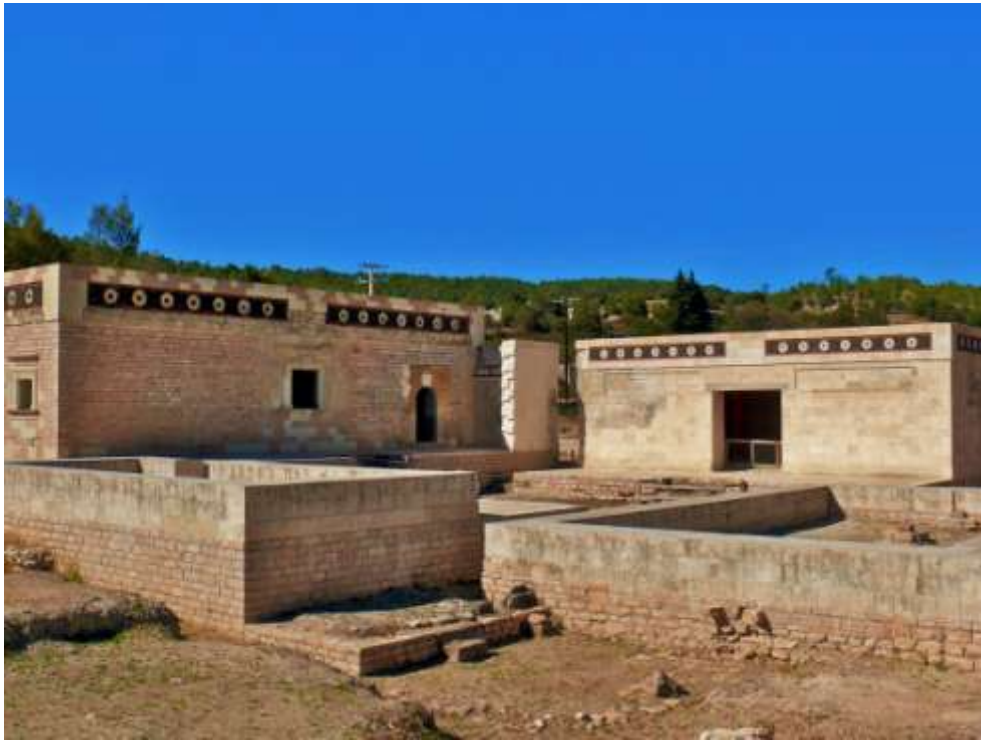
8.2 Edificio colonial en San Pedro y San Pablo Teposcolula conocido como Casa de la Cacica. (Fotografía de Ma. de la Luz Escobedo Gómez, 2008).
