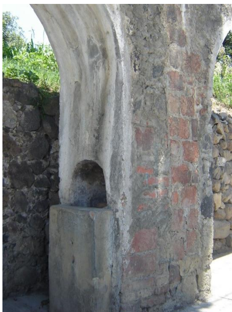
Fotografía 22. Pila en el acueducto “Los arcos”.
