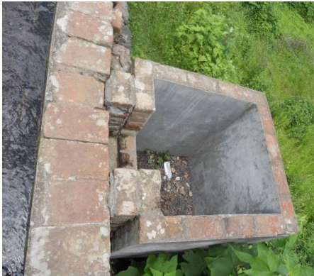
Fotografía 24. Pileta del puente
