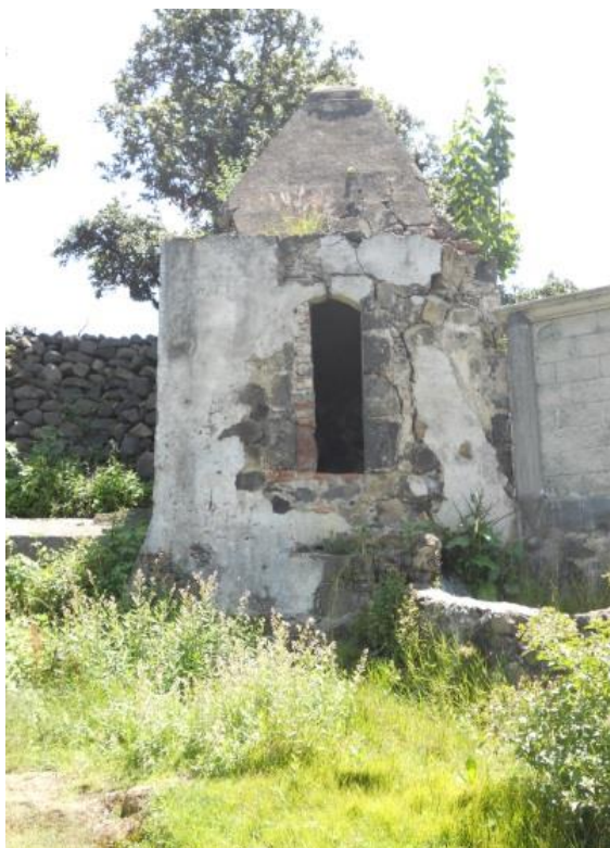
Fotografía 18. Fachada principal de la caja repartidora 1.
