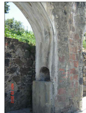
Fotografía que muestra la pila del acueducto "Los Arcos"
