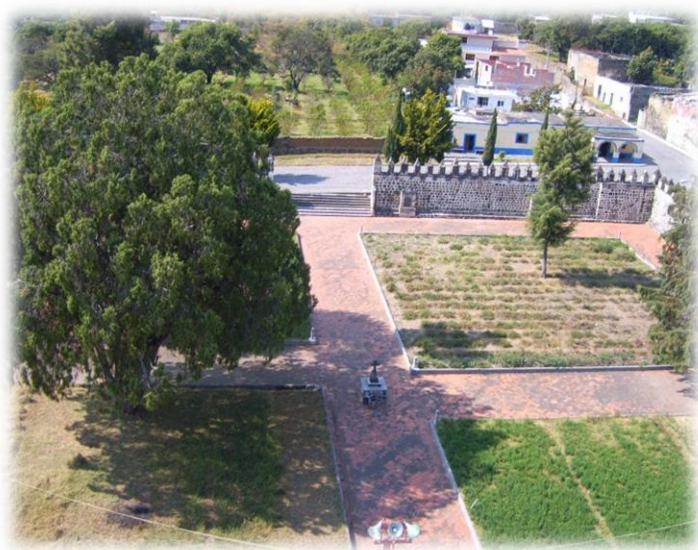
Fotografía 2. Atrio del convento, en donde se puede observar la barda atrial coronada por almenas, su acceso sur y la cruz atrial.
