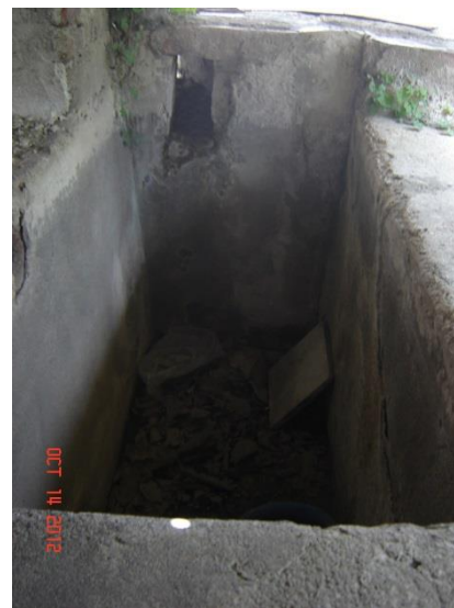
Fotografía 27. Pila en donde culmina la conducción de agua por el Acueducto 2
