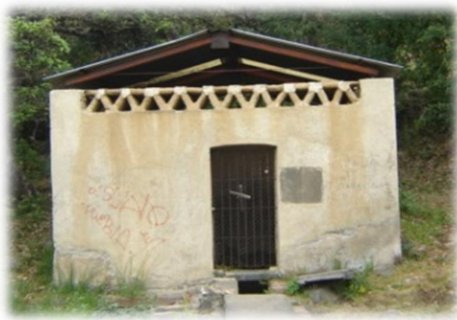
Fotografía 9. Fachada principal de la caja almacenadora como sistema de captación del agua del ojo “del Arco”.
