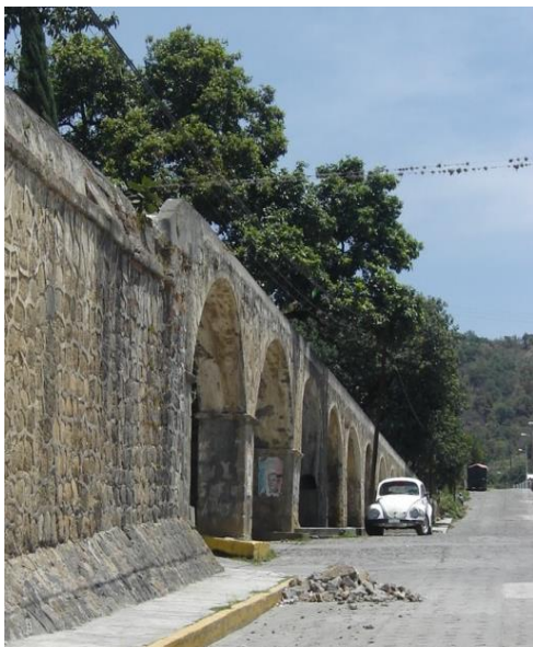
Fotografía 14. Acueducto “los arcos”.
