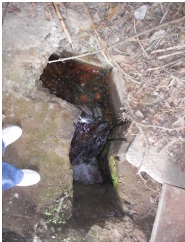
Fotografía 20, Sistema de distribución en el interior de la caja repartidora 1.
