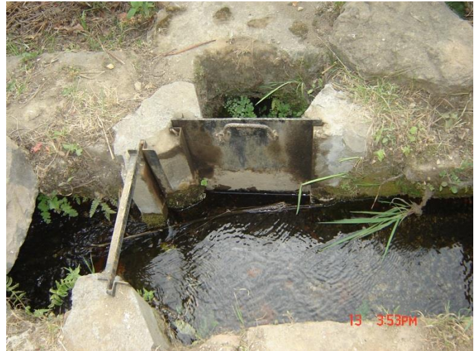
Fotografía 19. Sistema de compuertas.
