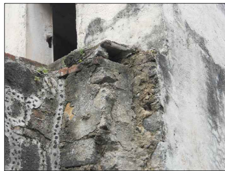
Fotografía F-1, sistema de conducción adosado, en donde se plantea hipotéticamente que este sistema funcionó por la entada de agua de la data de salida B y surtió de agua a la huerta del conjunto conventual de Tochimilco.
