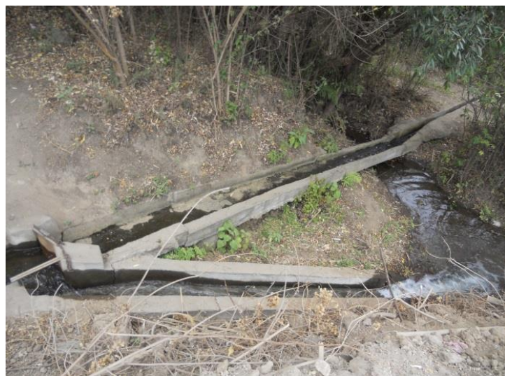
Fotografía 16. Acequias distribuidoras, partiendo de una acequia general para unirse a las secundarias. Dado que las acequias de distribución son dos y están situadas a las orillas, la cantidad de agua que ambas reciben es la misma.
