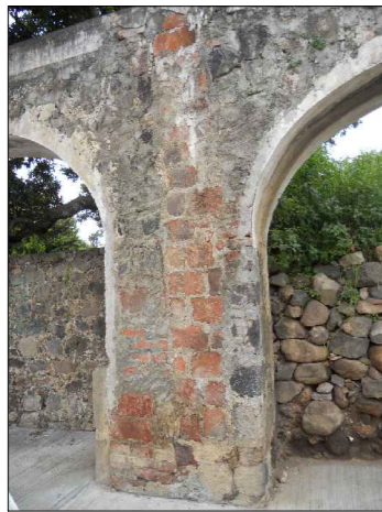
Soporte XI del acueducto, en donde se aprecia el cambio de material (tabique) siendo el área en donde se colocó la tubería de cobre que permitió conducir el agua hacia la pila.
