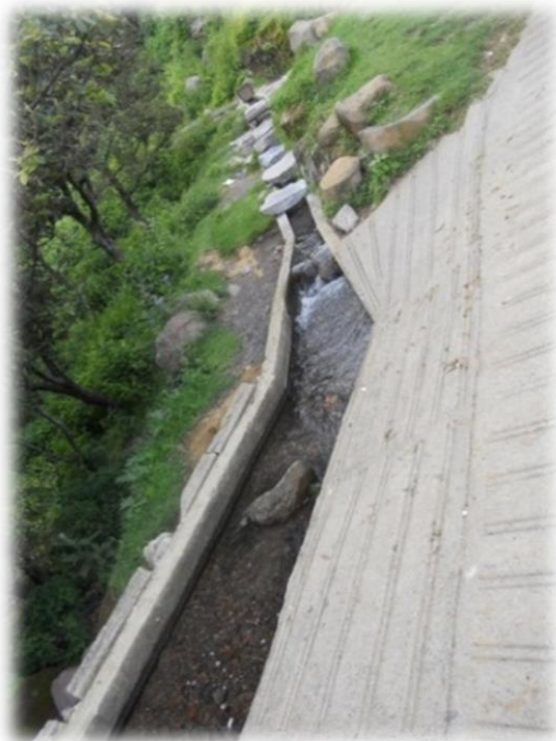
Fotografía 11. Piedra como obstrucción para regular la velocidad del agua.
