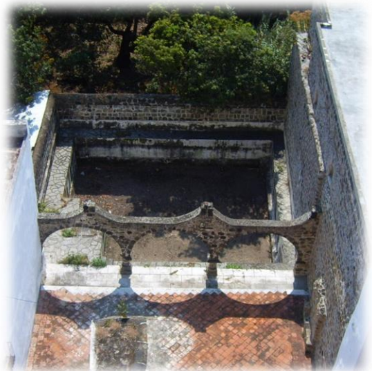
Fotografía 5. Aljibe. Nótese la arquería de medio punto coronada por volutas y la gran pila con almacenamiento para 1600,000l litros aproximadamente.
