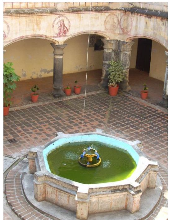
Fotografía 8. Pila del claustro. Situada en el centro del patio del claustro. Nótese en el perímetro de su base un pequeño canal para dirigir el líquido concentrado.
