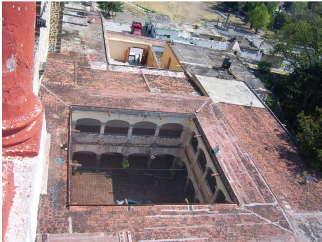
Fotografía 7. Vista aérea del claustro del convento franciscano de Tochimilco, en donde se puede apreciar las gárgolas de barro como sistemas de captación de agua pluvial, teniendo la finalidad de dirigir el agua hacia el patio del claustro.
