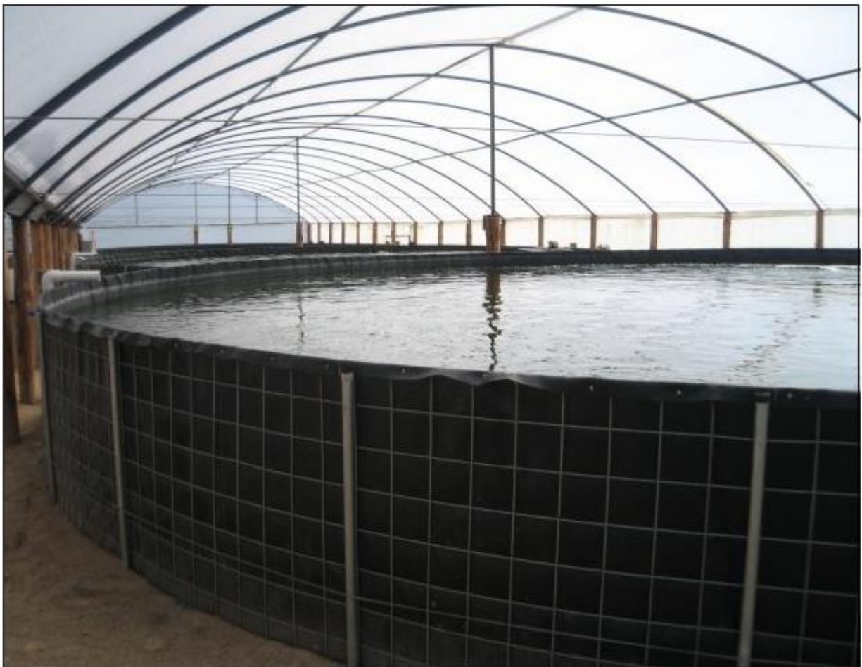
Figura 6, Estanques circulares de geomembrana
