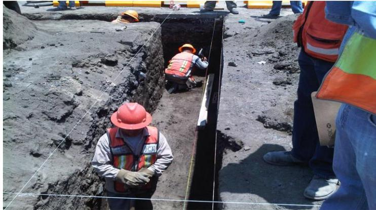
La finalidad de la construcción, obedece a la necesidad de contar con una guía que permita garantizar la posición y verticalidad correctas del equipo guiado durante el proceso de excavación del tramo de muro Milán en cuestión.
