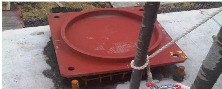
3. Colocar la base metálica del encapsulado aplicando 2 capas de primario.
