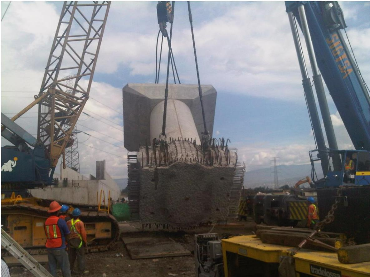
Después se retira el estrobo de la zapata para que el equipo pueda terminar el recorrido a su posición final.
