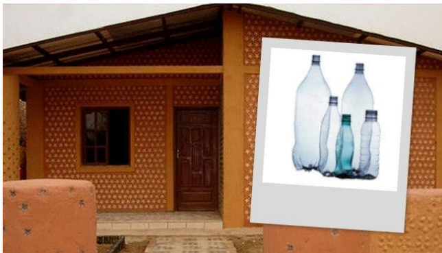
Fotografía 3: Construcción de casa con botellas de PET
