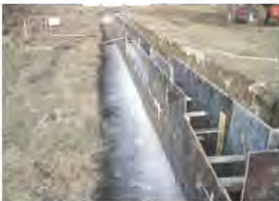
Proceso de construcción.
