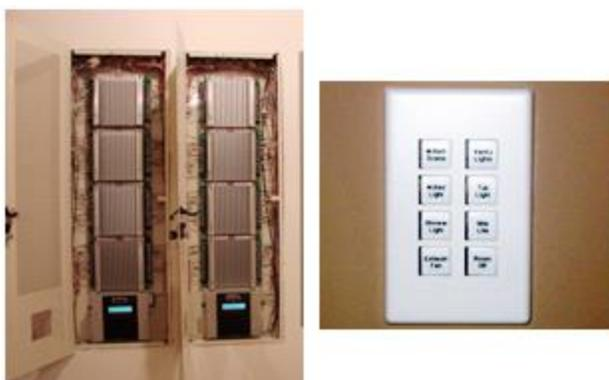
**Fig. 2.3: Módulos de Control Centralizados InFusion Vantage.**
