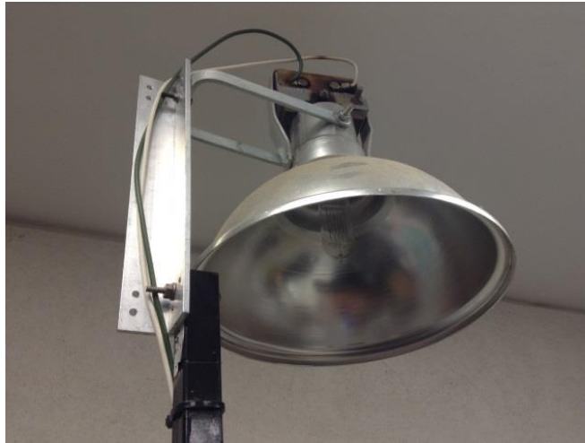
Figura 2-18. Lámpara de halógeno marca General Electric tipo CYX
