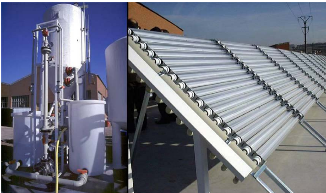
Figura 2. Planta solar del proyecto SOLARDETOX construida en Madrid, España (Malato et al. , 2009).
