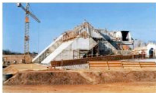
Img. 40 Imagen de la construcción.
