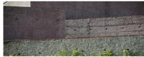
Img. 62 En esta imagen se puede observar el concreto armado con mármol blanco tinturado que se ocupó en el museo
