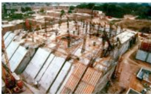
Img. 39 Imagen del museo durante la fase de construcción.
