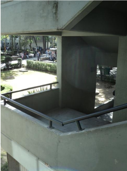
Concreto aparente acabados liso y martelinado en módulo de servicios
