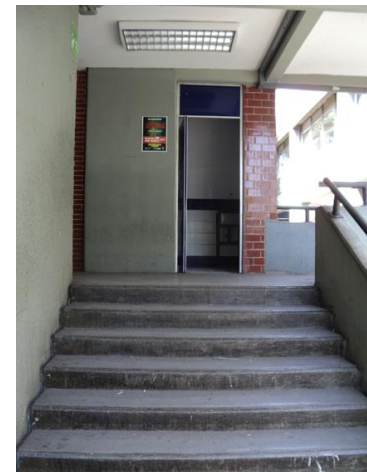
Escaleras de concreto aparente acabado final martelinado
