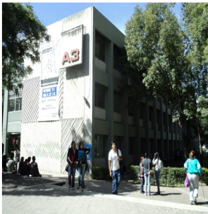
Abajo fachada sur Edificio A-3
