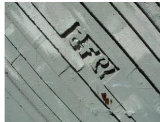
Textura en el concreto de muros cabeceros
