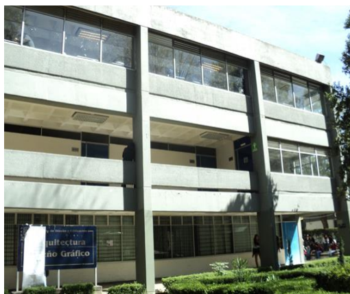
Texturas del concreto. Fachada poniente
