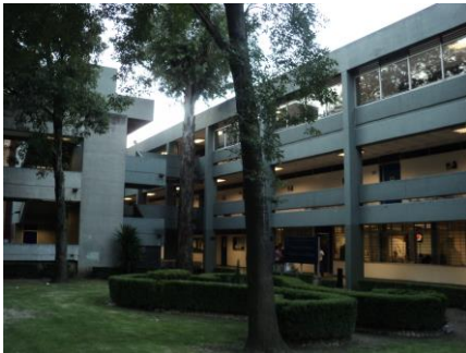
Foto 3. Fachada sur. El prisma rectangular presenta sustracciones, sin perder la identidad formal.
