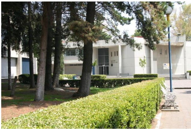
Edificio de Apoyo a la docencia
