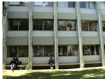
Foto 2.- Fachada oriente. El prisma rectangular presenta sustracciones que forman los vanos de las ventanas, éstas se refuerzan con las adiciones de las columnas, formando un hueco que se percibe en la fachada y se enmarca por las columnas y los faldones.
