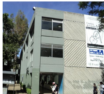
Textura en el concreto de muros cabeceros
