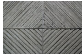
Textura en el concreto de muros cabeceros
