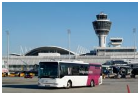
Figura 2.8. Aeropuerto de Múnich
