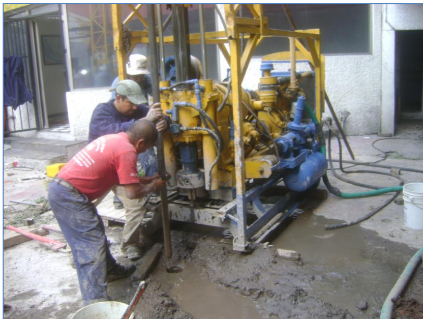
Foto 2.6 Equipo de perforación empleado
