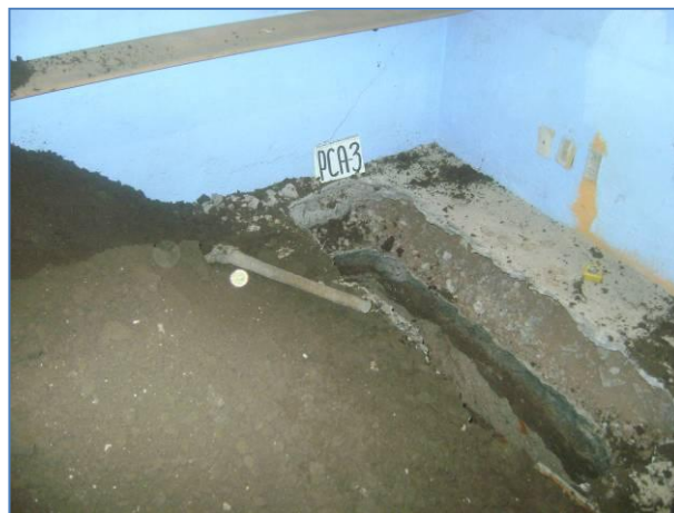
Foto 2.3 Excavación de pozo a cielo abierto (PCA-3)
