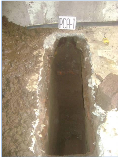
Foto 2.1 Excavación de pozo a cielo abierto (PCA-1)
