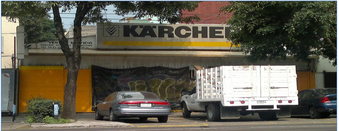
Fachada de predio donde se realizara la cimentación
