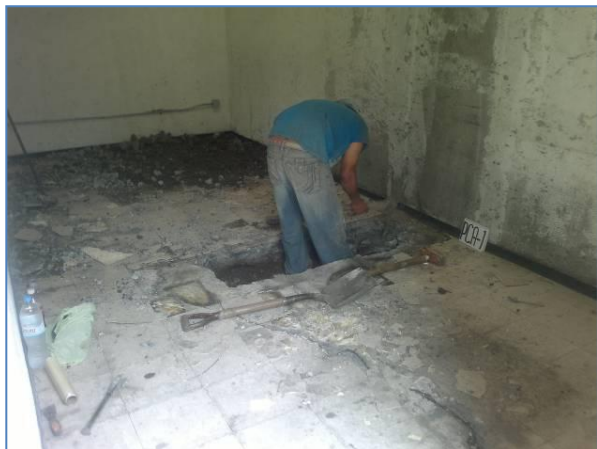
Foto 2.7 Excavación de pozo a cielo abierto (PCA-1)
