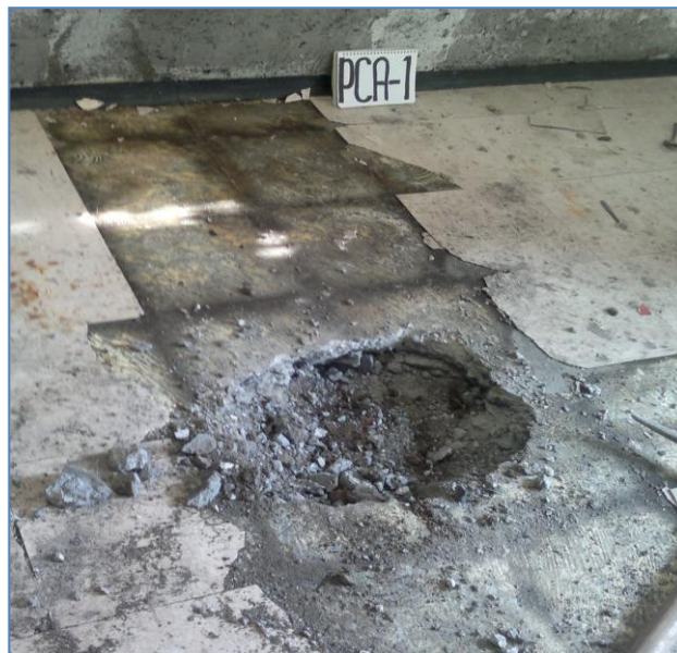
Excavación de poso a cielo abierto 1
