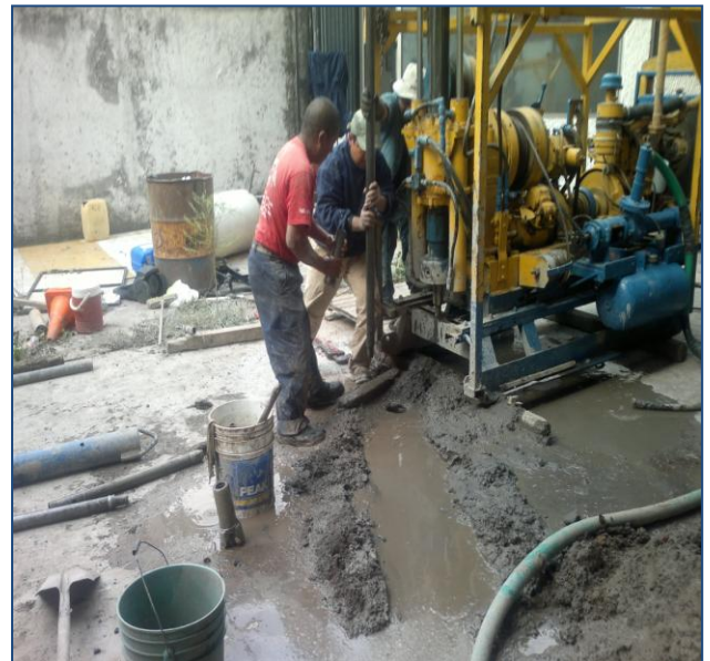
Realización de trabajos durante la perforación
