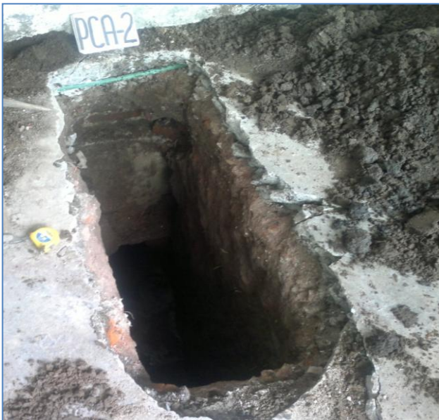
Excavación de pca-2 terminada
