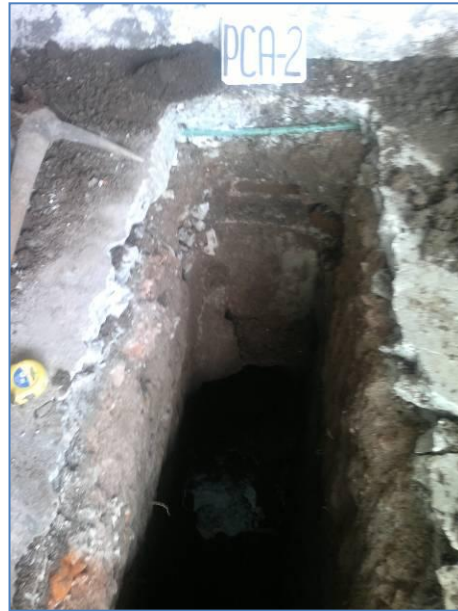
Foto 2.2 Excavación de pozo a cielo abierto (PCA-2)
