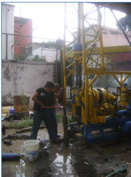
Foto 2.9 Equipo empleado para el sondeo profundo
