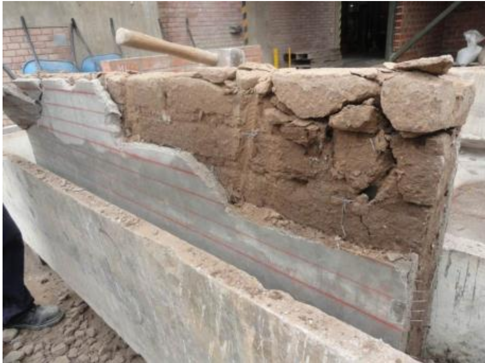
Figura 30. Muro experimental de adobe con recubrimiento Fuente: Pereyra et al. ; 2012.
