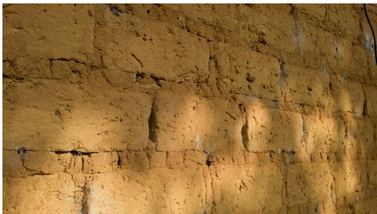
Figura 11. Construcción con adobes
