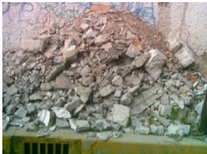
Figura 3. Impacto de los residuos de construcción Se observa obstrucción en la coladera que afectará al drenaje.
