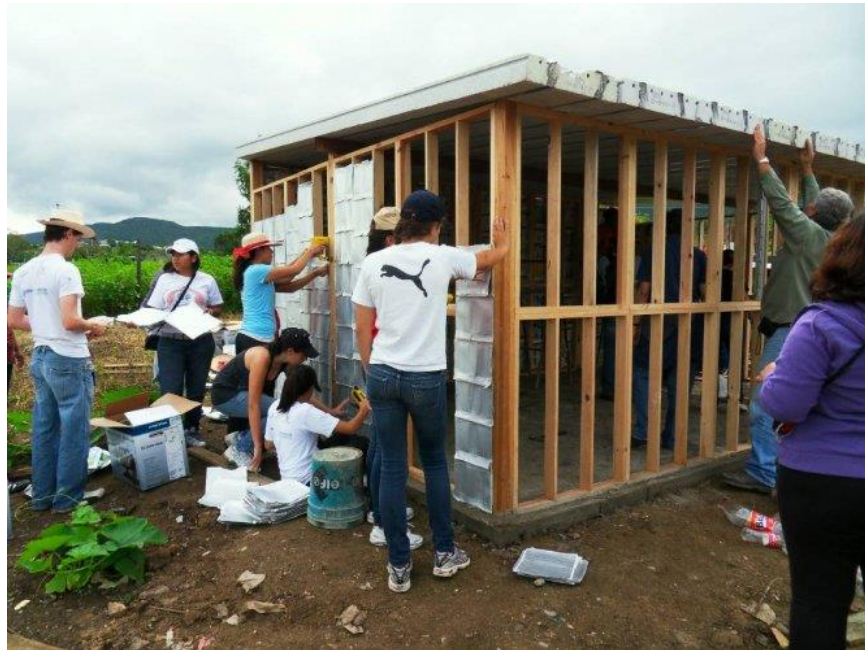
Figura 10. Casa fabricada con Tetra brick Fuente: Sikanda, 2010.
