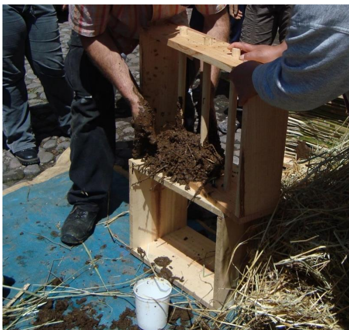
Figura 14. Construcción con bahareque
