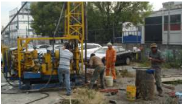
VISTA DE LOS SONDEOS PROFUNDOS REALIZADOS DENTRO DEL PREDIO
