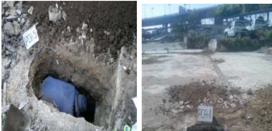
IMAGEN DE ALGUNOS POZOS EXCAVADOS.
