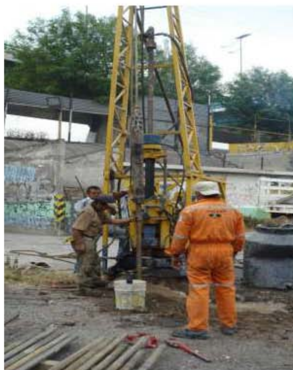
FOTOS DE LA EJECUCIÓN DE UN SONDEO PROFUNDO
