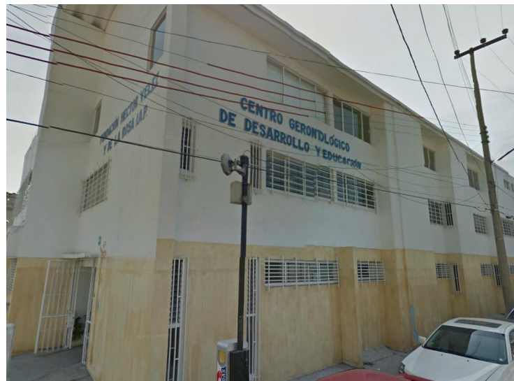
Fachada del centro sobre la calle Angeles
