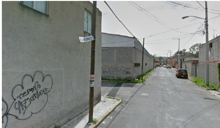
Vista de la fachada sur sobre la calle de Alcanfores
