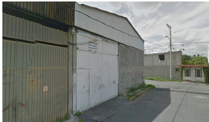
Vista de la fachada este sobre la calle Mises
