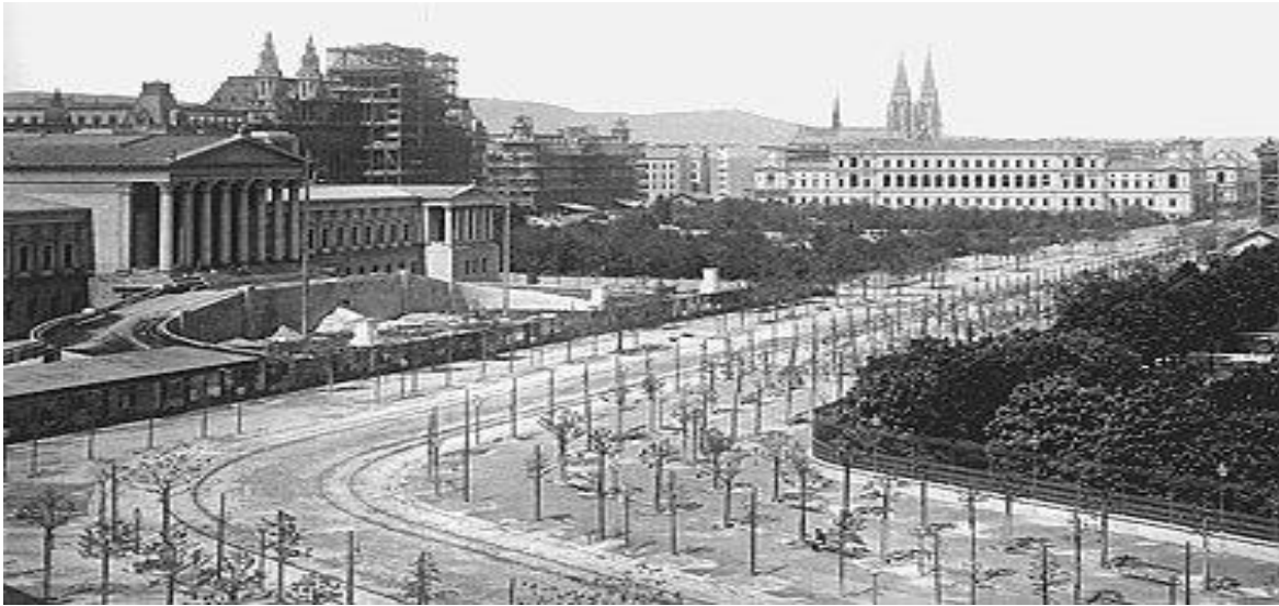
Imagen 3. Construcción del boulevard Ringstraße ; Viena, Imperio Austríaco. c. 1865.
