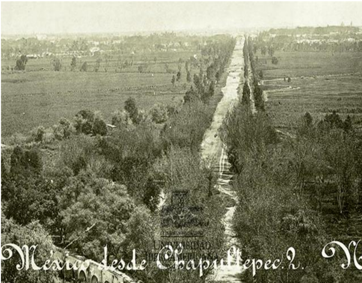
Imagen 75. Calzada central (18 m.) y camellones laterales (9 m.) con doble fila de árboles en Paseo Degollado. 1870.
