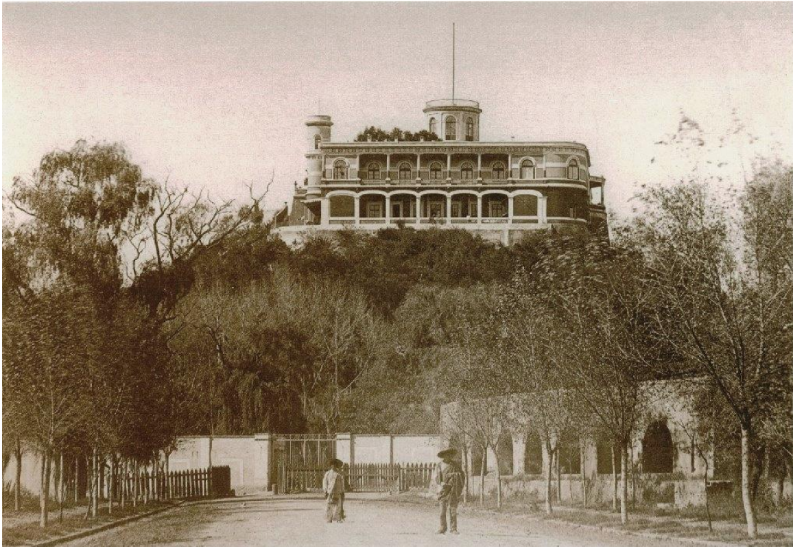
Imagen 104. Entrada al Parque Imperial y fachada oriente de la villa. 1866.
