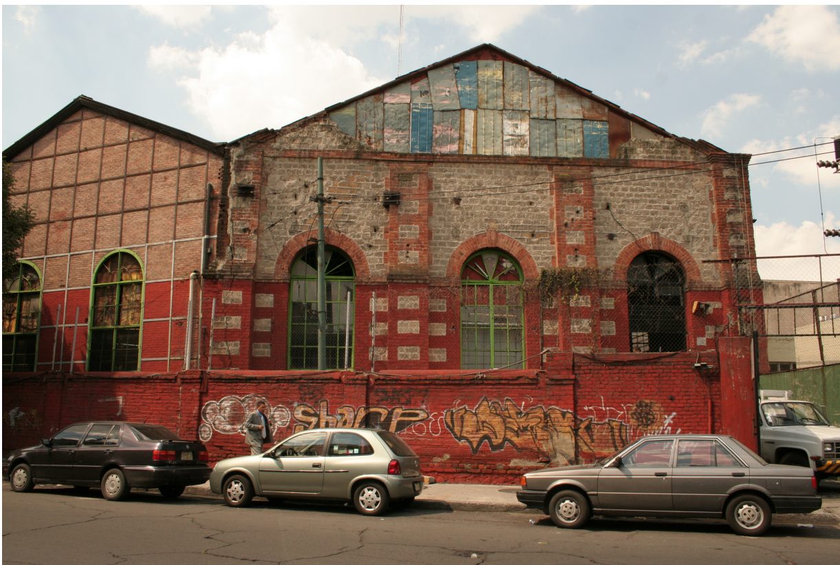
Condición en la que se encontraba el inmueble antes de su intervención Fotografía: Archivo CCEI
