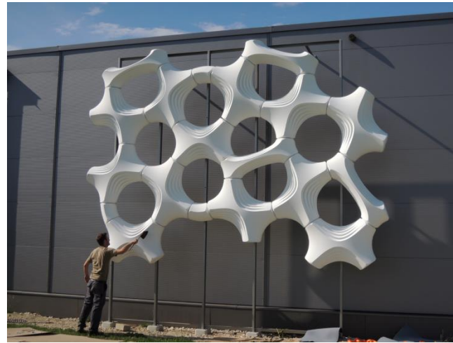
Imagen 4 Montaje de la fachada sobre bastidores metálicos.
