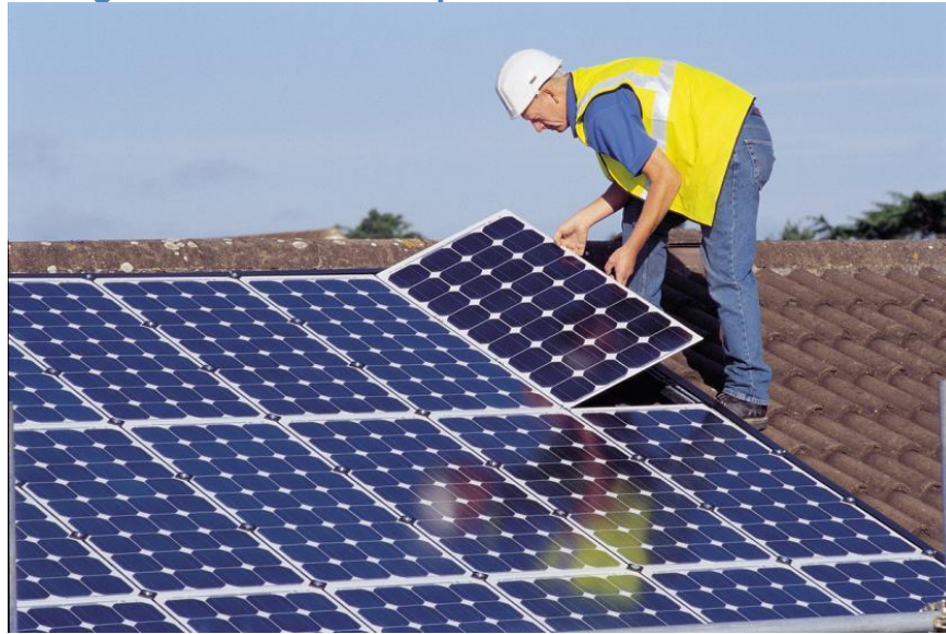
Imagen 5 Instalación de paneles solares fotovoltaicos
