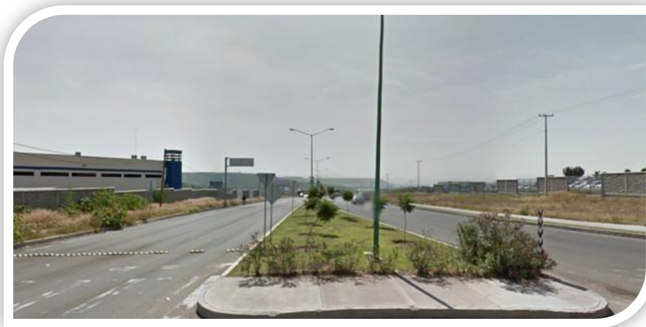
I27.- Vialidad Provincia Juriquilla de Norte a Sur. Se encuentra al Oriente del terreno. (Foto tomada por el autor).
