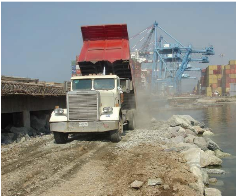
Figura 71. Fotografía de tiro de roca de núcleo de dique.
