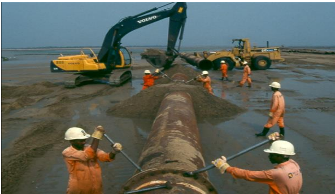
Figura 22. Colocación de tubos en el área de reclamación
