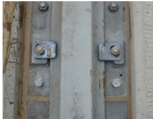
Figuras 64 y 65. Colocación de Grout para relleno y anclaje de riel.
