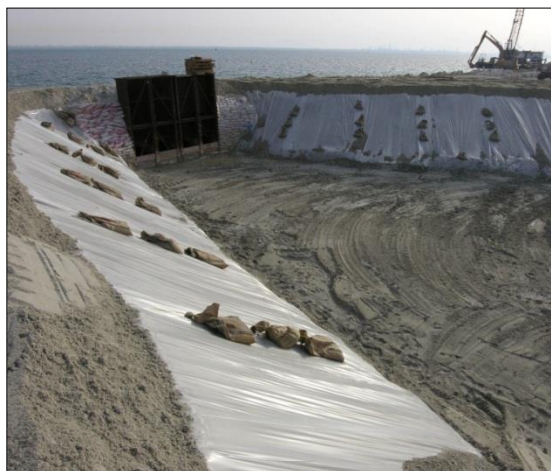
Figura 24. Trabajos previos: plástico de protección del talud de bordos
