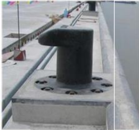
Figuras 58 y 59. Colocación de bitas.
