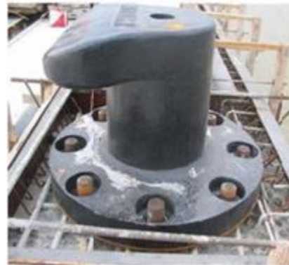
Figuras 58 y 59. Colocación de bitas.
