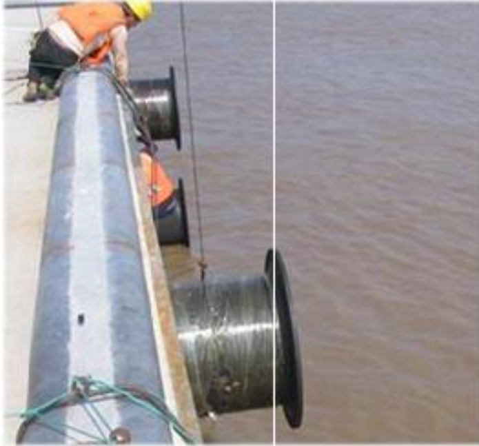
Figura 56. Alineamiento y colocación de cono de absorción de defensa marina
