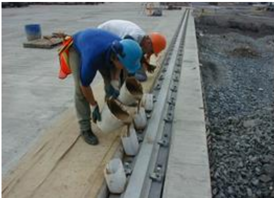
Figuras 64 y 65. Colocación de Grout para relleno y anclaje de riel.
