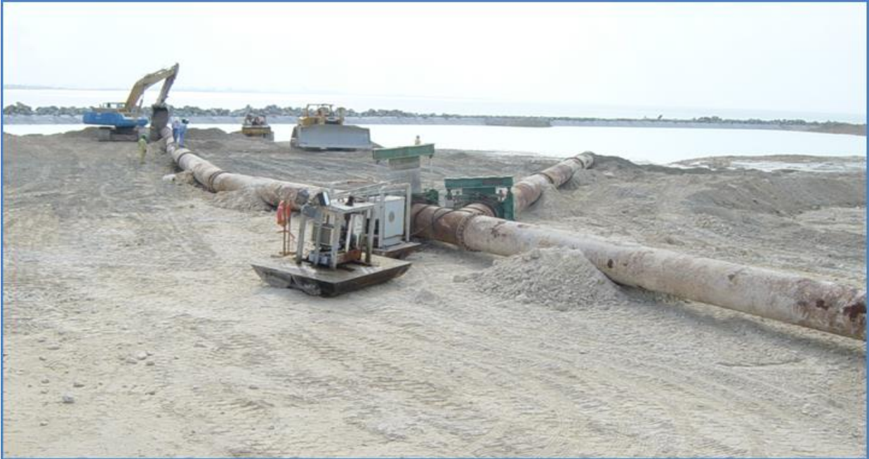
Figura 21. División de la tubería hacia diferentes áreas
