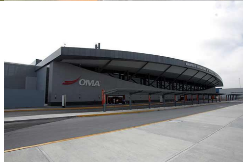
Fotos 61, 62 y 63: En la esquina superior izquierda (en orden de construcción), la Terminal 'A', a la derecha, la 'C' y abajo, la Terminal 'B'.
