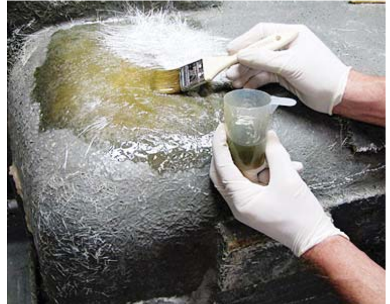
Aplicación de resina a fibra de vidrio
