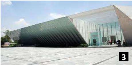
3_la etapa de consolidación y apropiación del objeto arquitectónico, una vez que se ha terminado su construcción.
