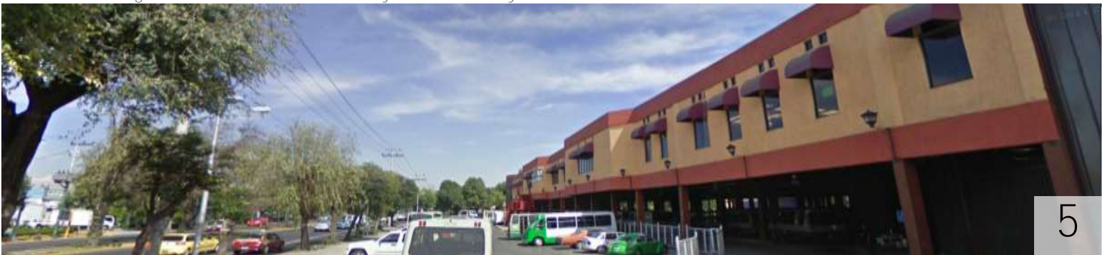
Larguillo de la calle Francisco Goytia oficinas de SETRAVI, Estación del Tren ligero Francisco Goitia
