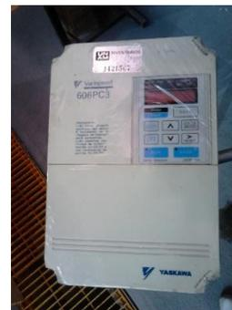
Figura 3.2 - Variador de Velocidad del túnel de viento
