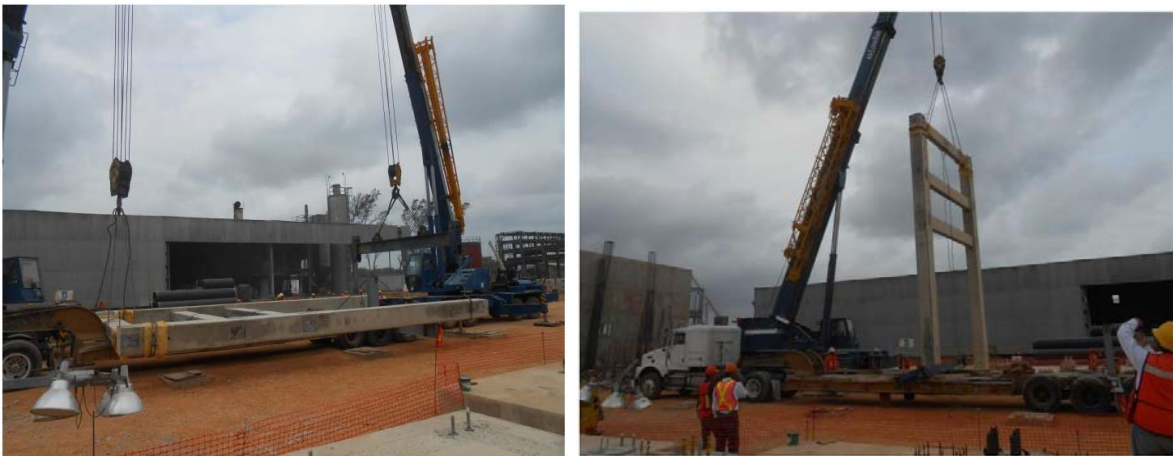
Imagen 6.4 Maniobras para izaje de marcos transversales y empotramiento en dados tipo candelero.
