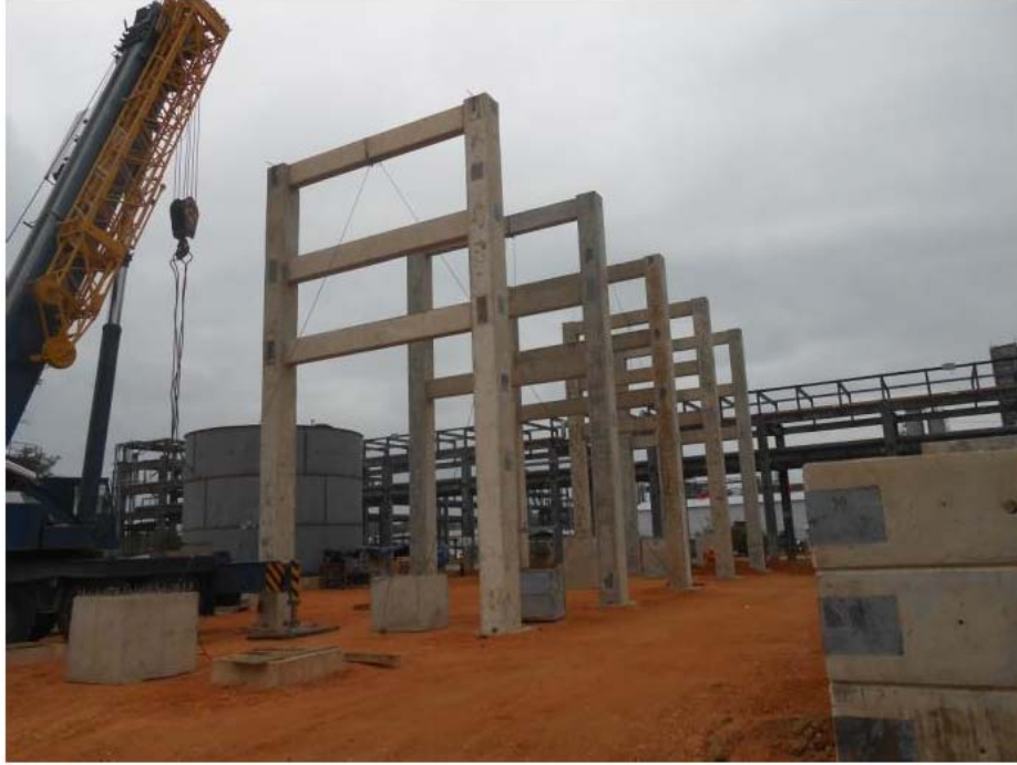
Imagen 6.5 Estabilización, nivelación y conformado de marcos de Rack
