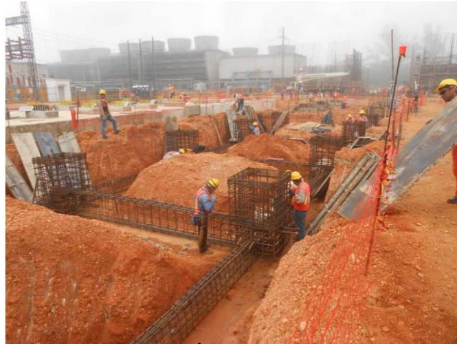
Imagen 6.1 Habilitado de refuerzo en trabes de liga y candeleros para la cimentación de un Rack
