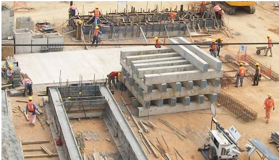
Imagen 6.6 Construcción de vigas longitudinales
