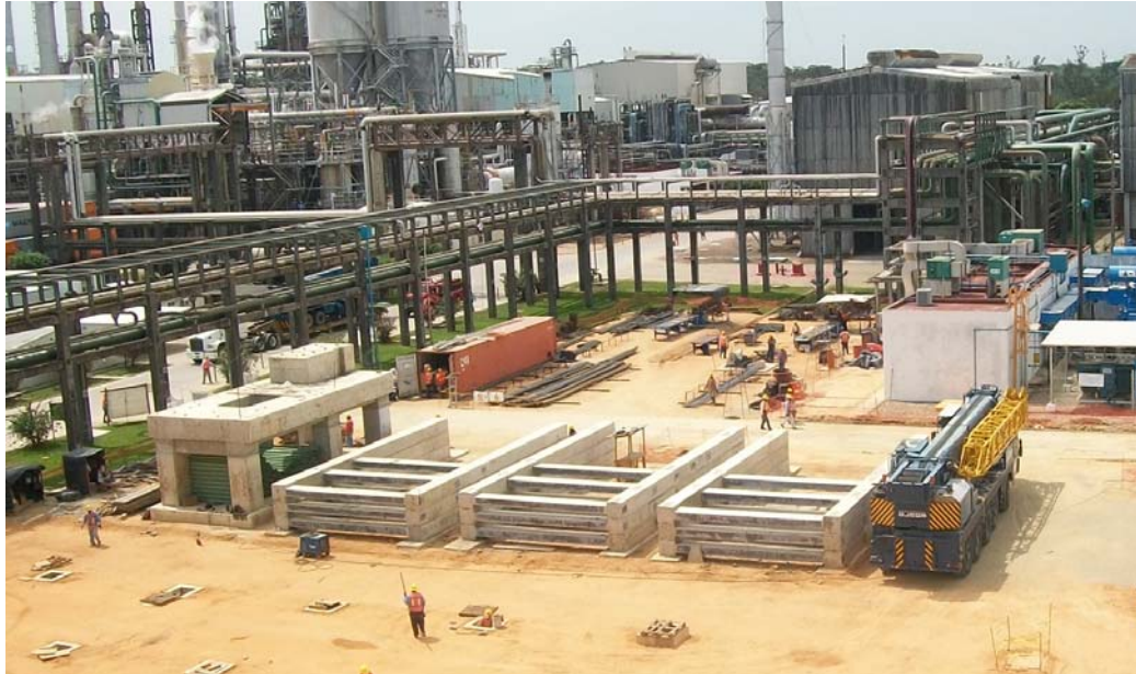
Imagen 6.3 Construcción y estiba de marcos transversales de Rack de Tuberías
