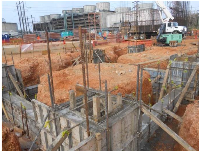
Imagen 6.2 Colado monolítico de la cimentación para un Rack de Tuberías
