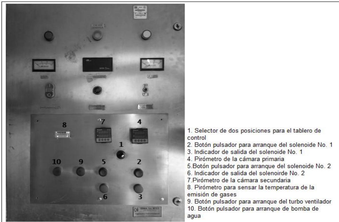
**Figura 4.26 Configuración del tablero de control respecto al funcionamiento para incinerador, turbo ventilador y bomba de agua del caso de estudio**
