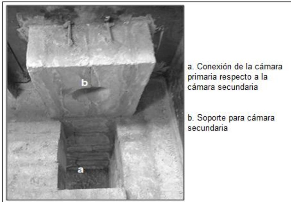
**Figura 4.9 Fotografía de la abertura de conexión con cámara secundaria y soporte para cámara secundaria**
