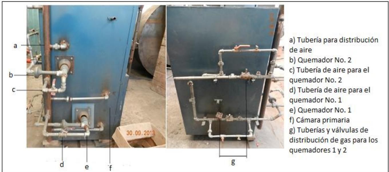
**Figura 4.25 Configuración del tren de válvulas para el combustible (gas LP) e inyección de aire en el caso de estudio**
