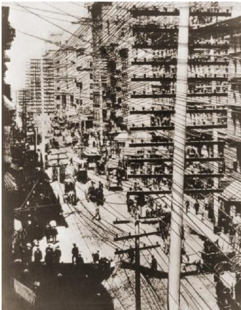
Figura 2.1 New York (Exceso de líneas telefónicas)
