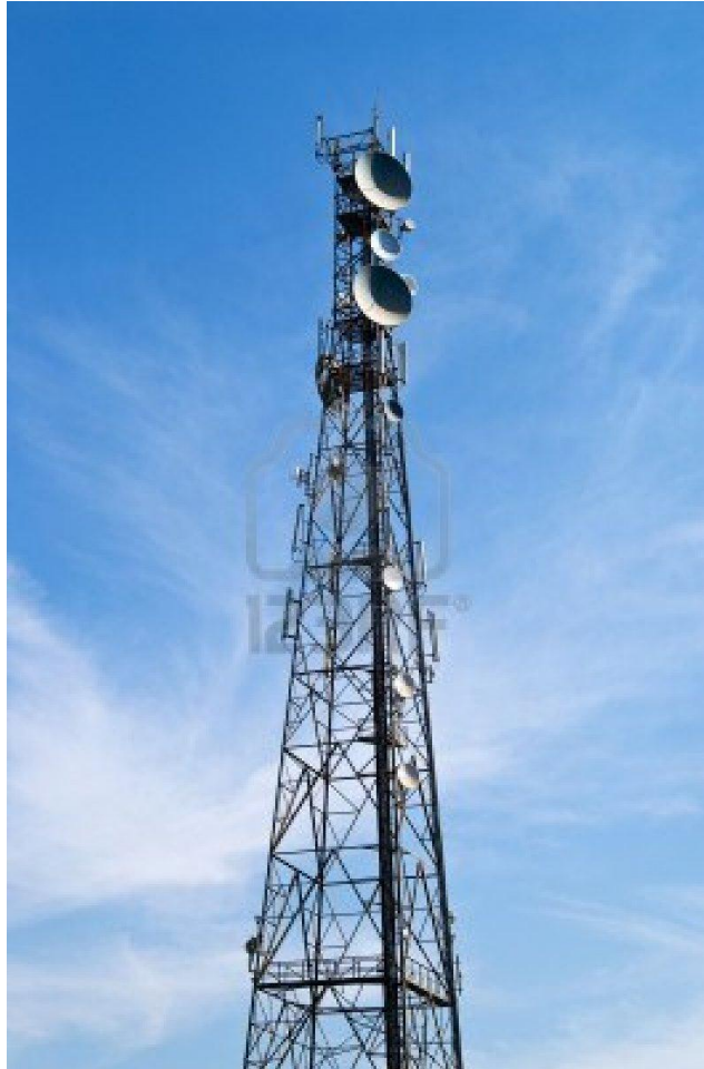
Figura 3.5 Torre de la telecomunicaciones con antenas para TV, radio y de teléfonos portátiles
