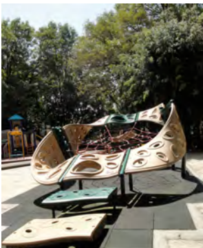
5- recubrimiento de caucho para amortiguar caídas
