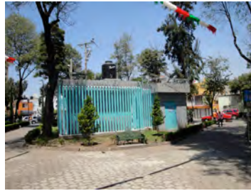
2- Instalación de agua
