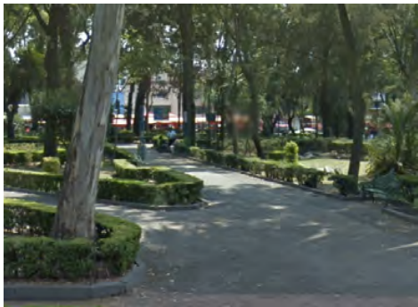
3- Estado de las jardineras y el pavimento
