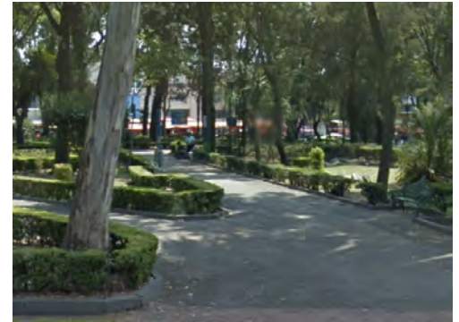
4- Estado de las jardineras y el pavimento
