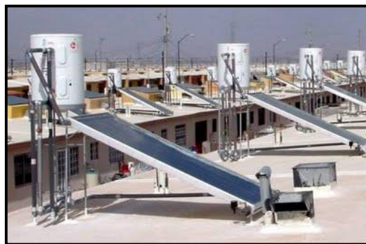
Figura II.37. Calentador solar de tubos paralelos.
