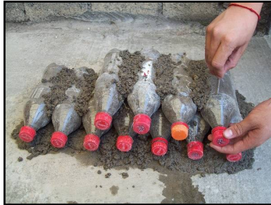
Figura III.22. Acomodo de la segunda hilada de eco - ladrillos.
