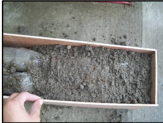
Figura III.36. Colado de la cadena de cerramiento.
