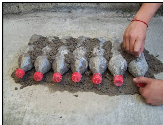
Figura III.21. Primera hilada de eco - ladrillos.
