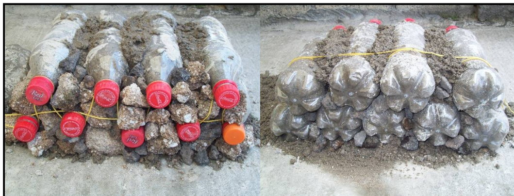
Figura III.25. Rellenado de huecos para un mejor revestimiento.
