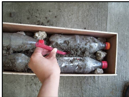
Figura III.35. Colocación de varas de carrizo en dirección vertical.
