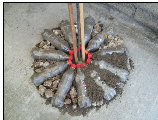
Figura III.30. Rellenado de los huecos formados entre los lomos de los eco - ladrillos.
