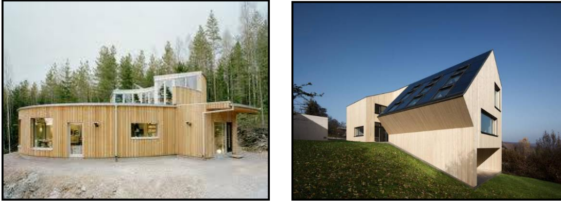
Figura II.15. La forma de la vivienda contribuye a las pérdidas o ganancias caloríficas.
