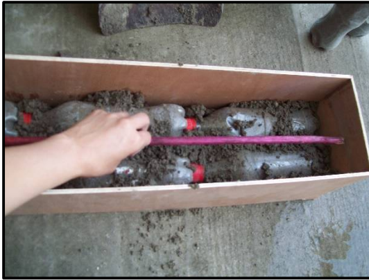
Figura III.33. Primera hilada de eco - ladrillos. Figura III.34. Segunda hilada de eco - ladrillos.
