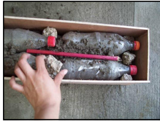
Figura III.33. Primera hilada de eco - ladrillos. Figura III.34. Segunda hilada de eco - ladrillos.
