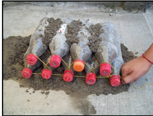
Figura III.24. Atado de las tapas o cuellos de los eco - ladrillos.
