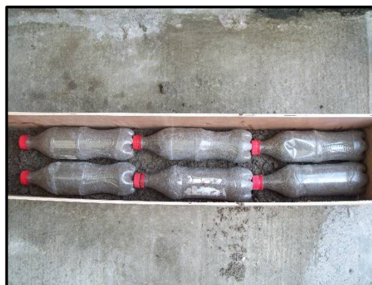
Figura III.32. Acomodo de eco - ladrillos.
