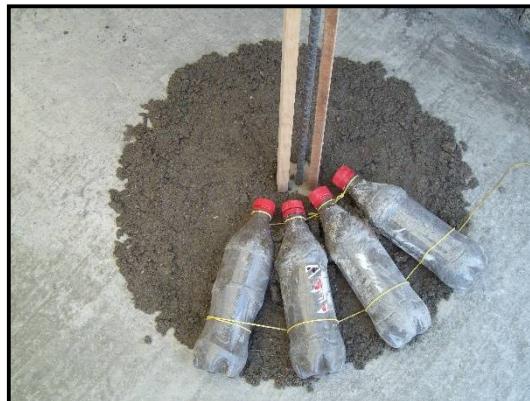
Figura III.28. Atado de tapas y bases de eco - ladrillos.
