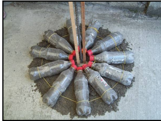
Figura III.29. Formación del anillo simétrico en cada hilada.
