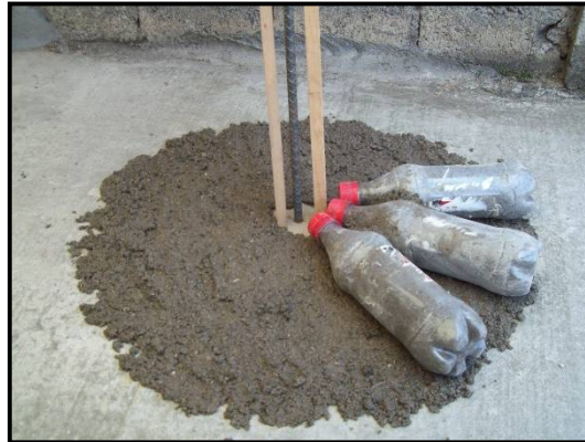
Figura III.27. Colocación de la primera hilada de eco - ladrillos.
