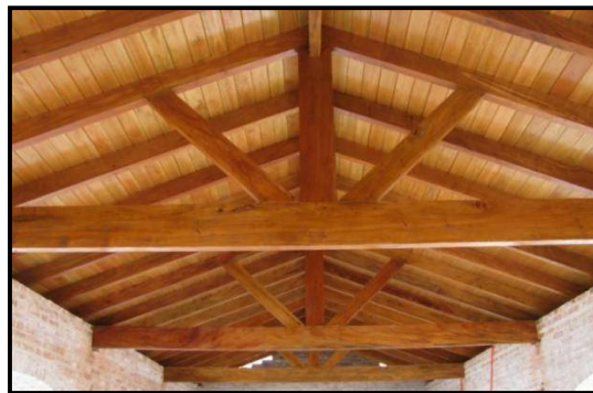
Figura III.38. Estructura de techo.
