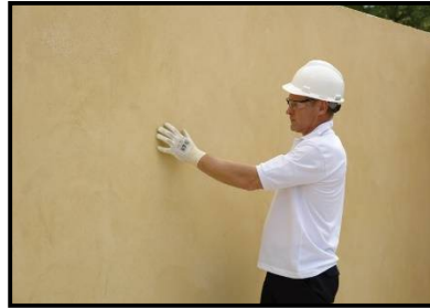
Figura III.93. Revoque en muros.
