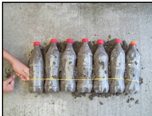
Figura III.23. Atado de las bases o cinturas de los eco - ladrillos.
