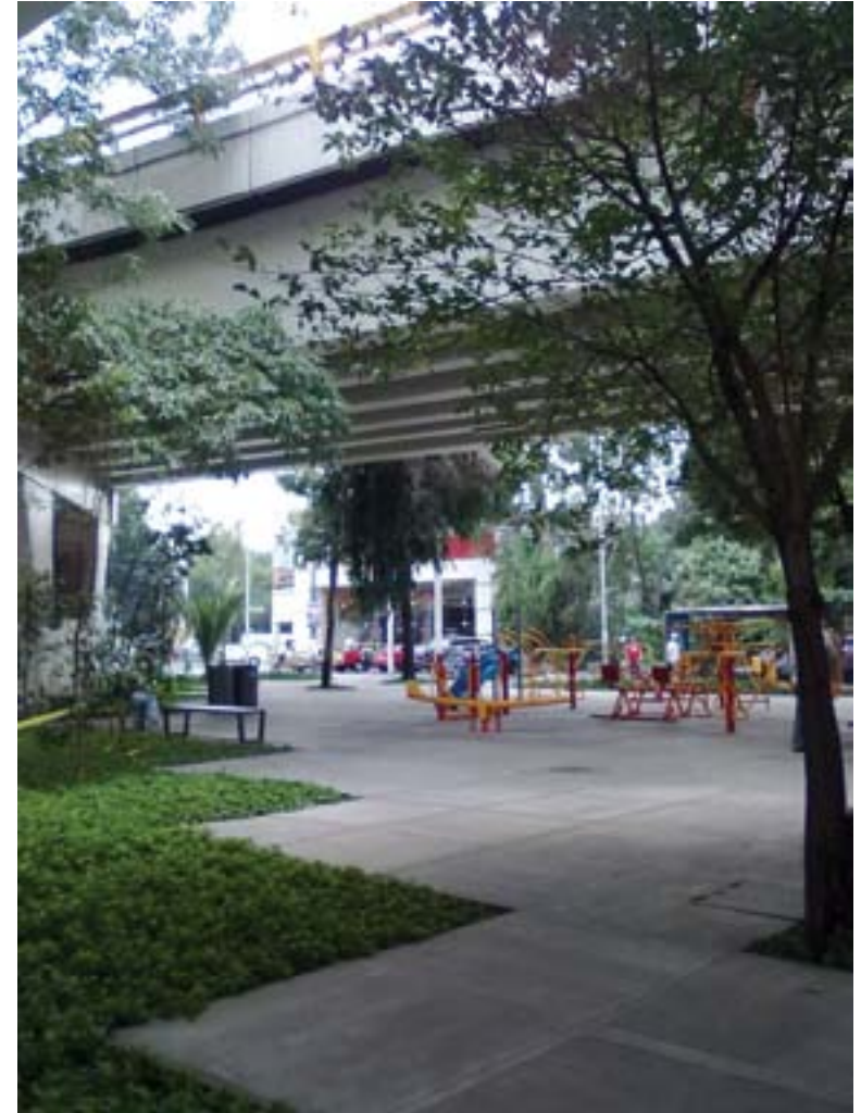
Alternativa de bajopuentes en la Ciudad de México
