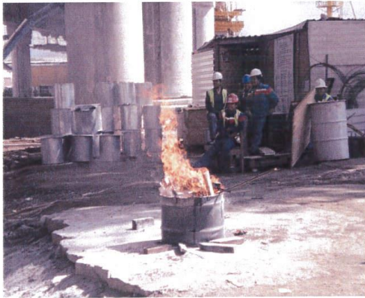
Situación de emergencia de incendio por mitigar
