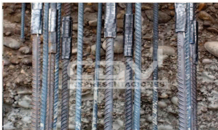
Figura Nº 5 Camisa de acoplamiento de acero estampado en frío.
