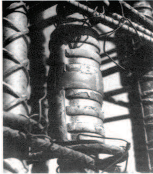
Figura Nº 9 Camisa de acoplamiento de acero forjado en caliente.
