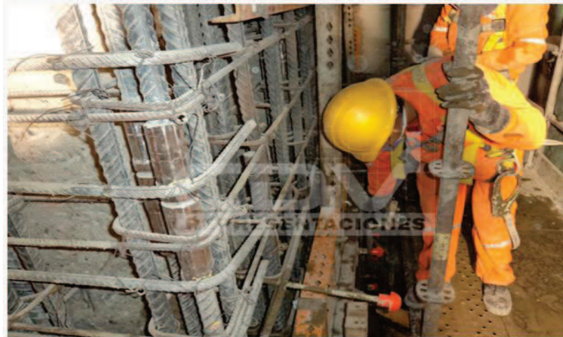
Figura Nº 6 Camisa de acoplamiento estampado en frío en un elemento.
