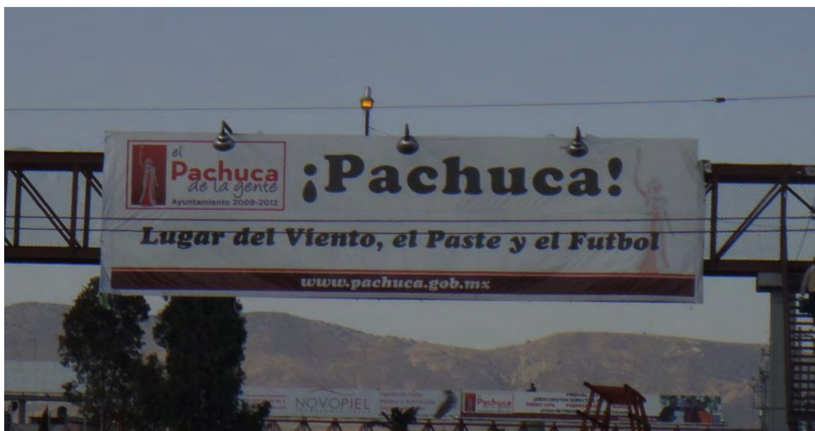
Figura 3.44 Pachuca: puente peatonal a la entrada de la ciudad.
