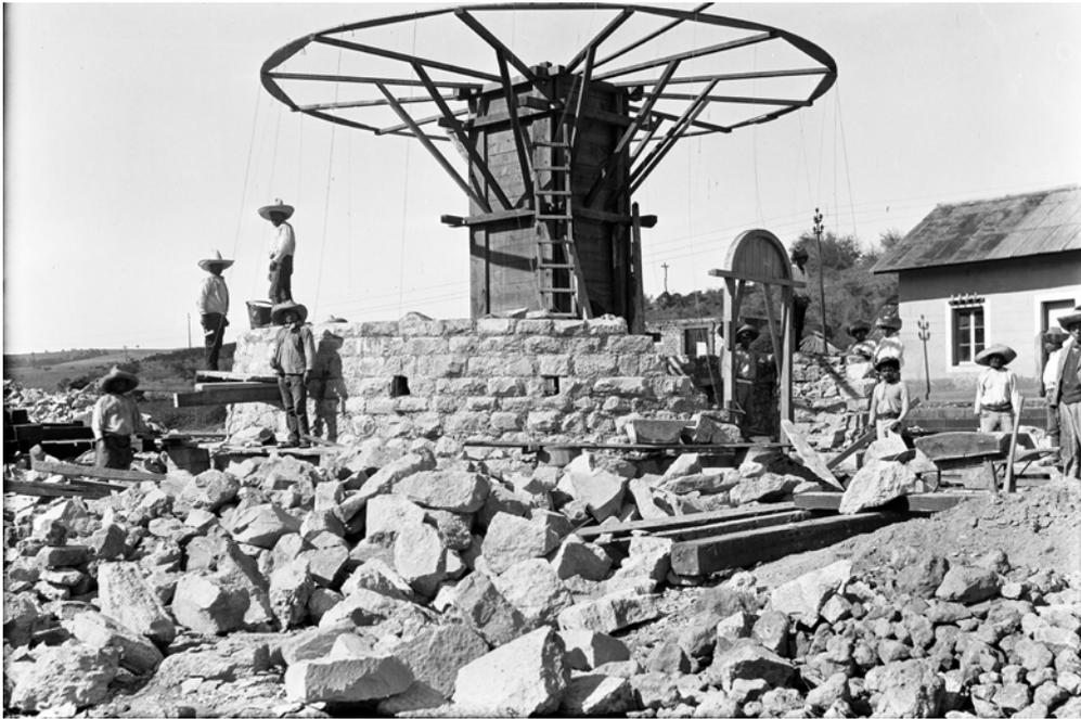
**FIGURA 5.** Durante el régimen de Porfirio Díaz, la infraestructura para el ferrocarril aumentó en proporción al número de kilómetros construidos. En la imagen observamos la construcción de una toma de agua en Boca del Monte. Fuente: Biblioteca especializada /CEDIF/CNPPCF/Conaculta.
