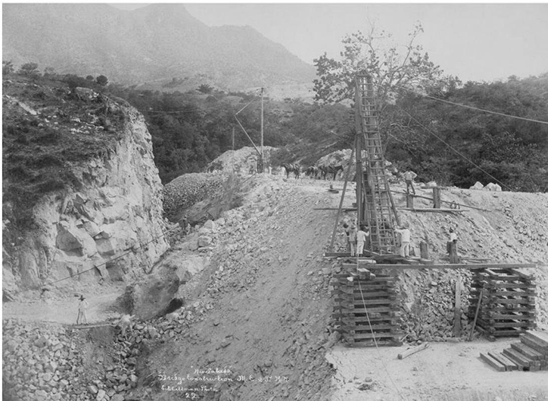
**FIGURA 3.** La imagen muestra la reconstrucción de un terraplén de la vía ciudad de México-Cuernavaca. Como se observa, la grava suelta requería de un mayor reforzamiento, ya que, durante las intensas lluvias, los terraplenes se desgajaban e interrumpían el flujo de los ferrocarriles. Fuente: Biblioteca especializada /CEDIF/CNPPCF/Conaculta.
