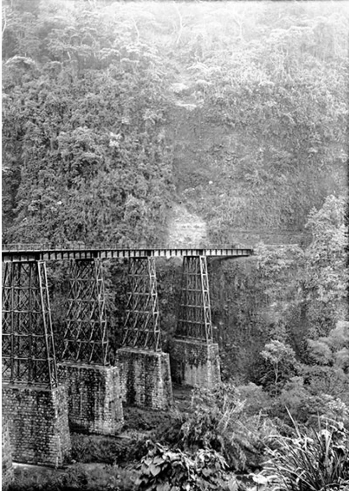
**FIGURA 4.** La obra de ingeniería de los puentes de la vía del ferrocarril México-Veracruz refleja el elaborado trabajo de diseño en la construcción de puentes y el impacto de su presencia en la percepción de los viajeros y los pobladores locales. En la imagen se observa el puente de Metlac. Fuente: Biblioteca especializada /CEDIF/CNPPCF/Conaculta.
