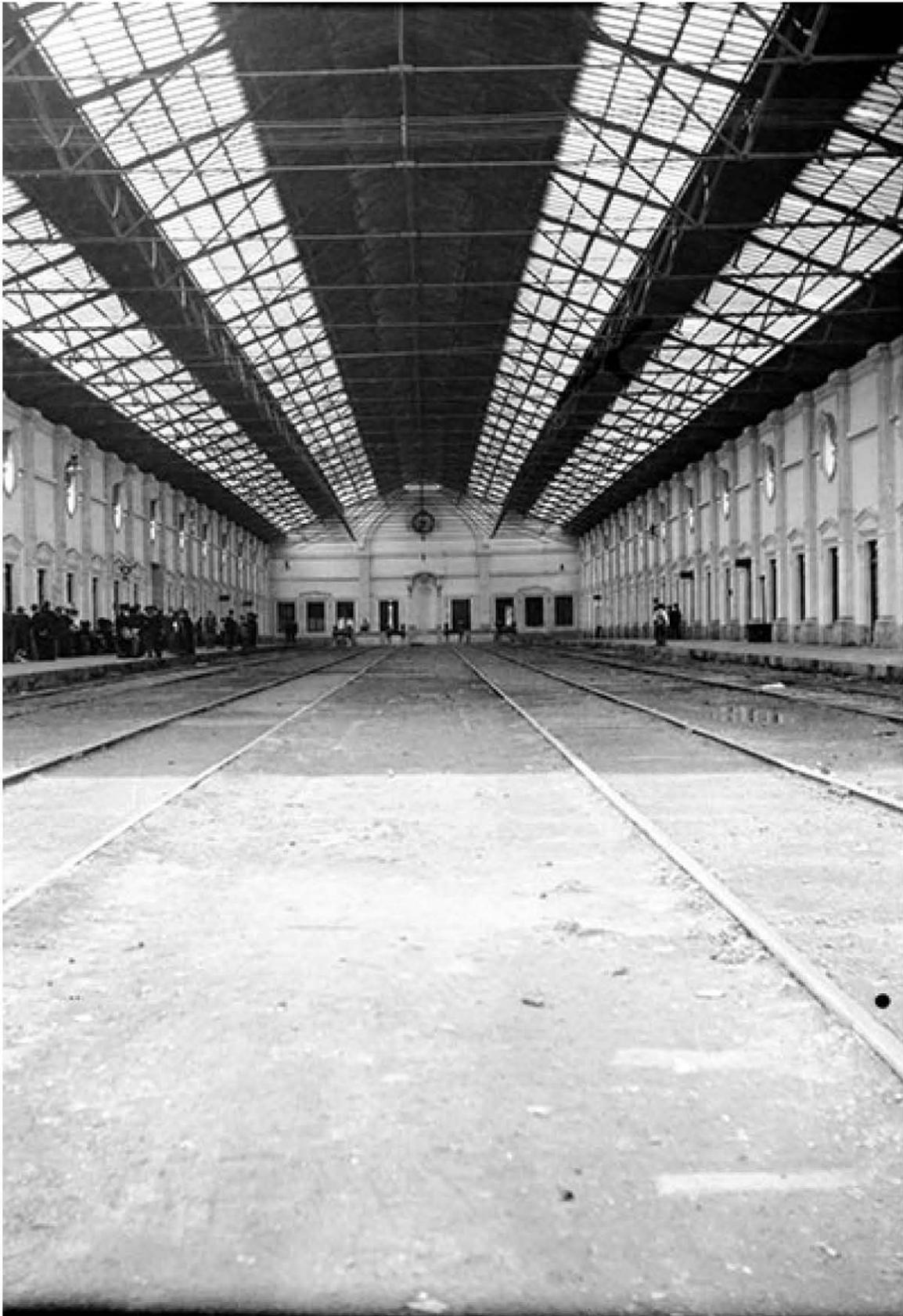
**FIGURA 42.** En la fotografía se observan los andenes de la estación Buenavista. Como se puede apreciar, la arquitectura refleja los elementos del concepto modernista europeo con el uso de acero y los ventanales grandes. Biblioteca especializada /CEDIF/CNPPCF/Conaculta
