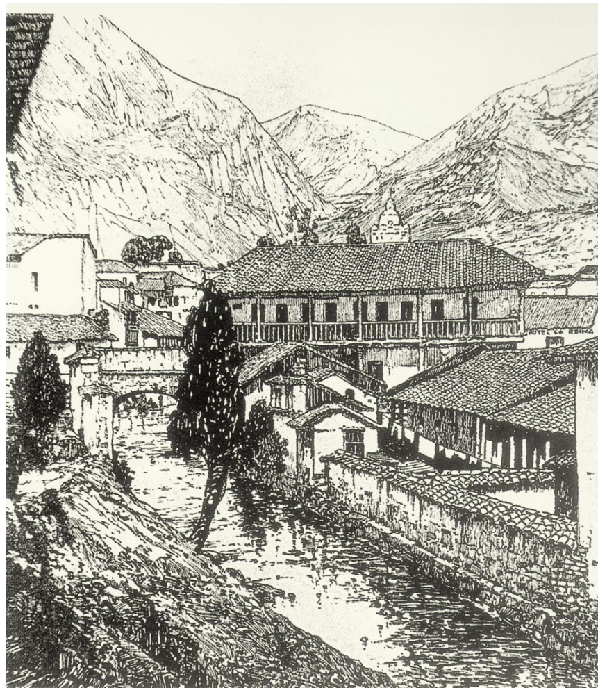
IMAGEN 3. Grabado del Puente de San Francisco PuentesobreelríoSanFranciscoqueunelaParroquiadelacatedralconlaparroquiadeLasNieves
