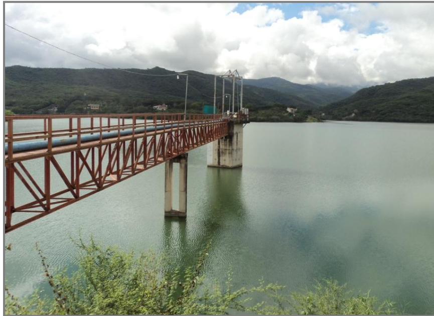
Figura 3.3. Presa Jalpan: torre de operación.
