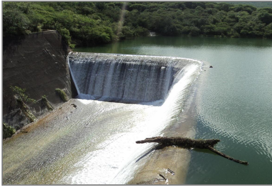
Figura 3.4. Presa Jalpan: cortina de la presa.
