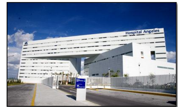
FACHADA PRINCIPAL DEL INMUEBLE.
