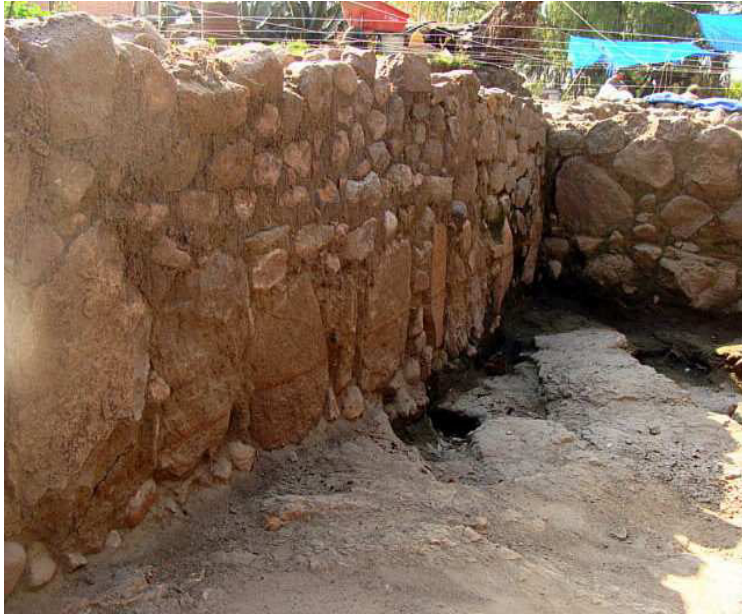
Vista norte-sur de la cara externa del muro perimetral poniente. Se observa el sistema de carga estructural de los muros del conjunto, a base de grandes rocas.
