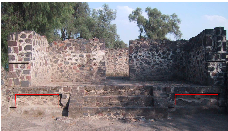
Basamento con tableros en forma de U invertida, en el conjunto de Tetitla.
