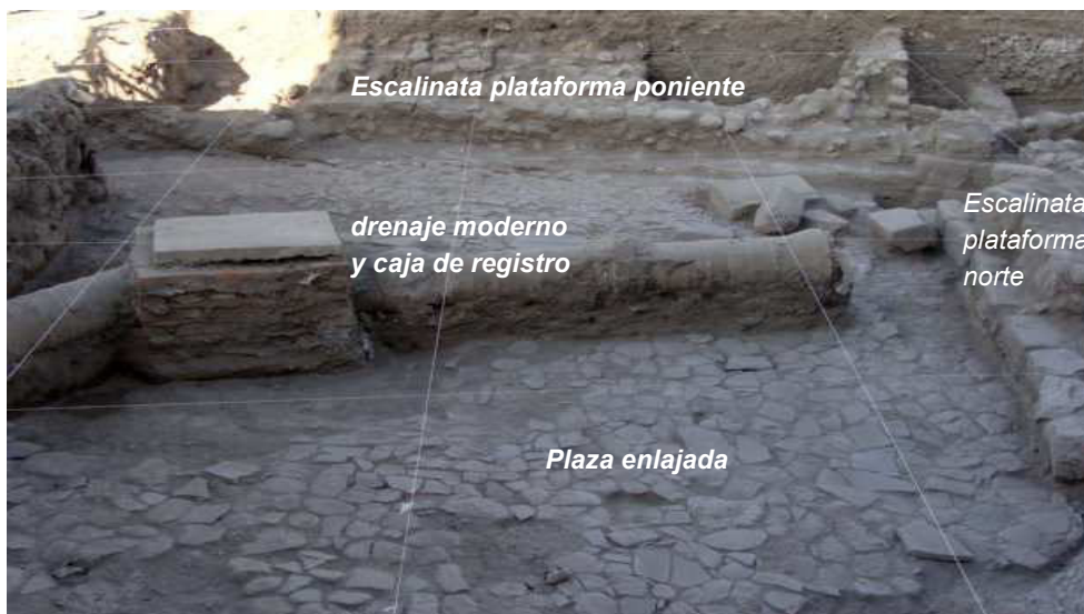
Vista E-W. Plaza enlajada y drenaje que afectó los vestigios.
