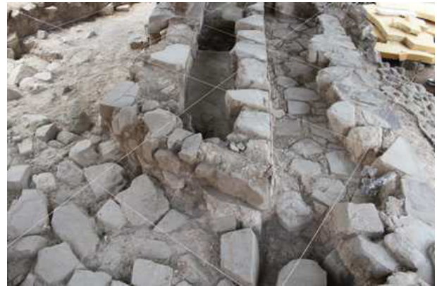
Edificio J, adoratorio superior, Monte Albán. Se observan muros desplantando de un piso enlajado. Fotografía cortesía de Miguel Ángel Cruz González.
