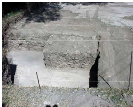
Altar 1. Construcción cuadrangular localizada en la esquina NW de la unidad arquitectónica E.
