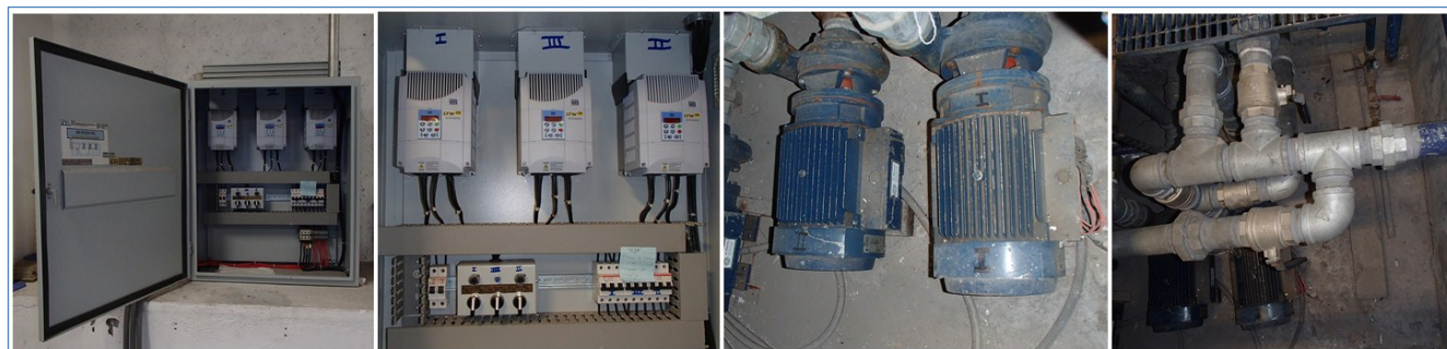
Figura 118.- Control del sistema de bombeo para el canal de oleaje del Laboratorio de Costas y Puertos.
