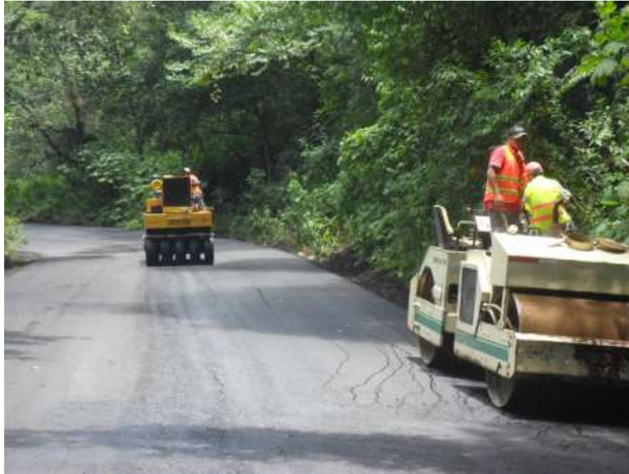
Fig. III 40 Compactador neumático finalizando detalle de carpeta asfáltica.
