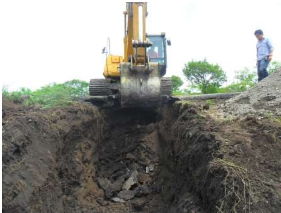
Fig. III. 13 Excavación para la colocación de tubería, primera sección.
