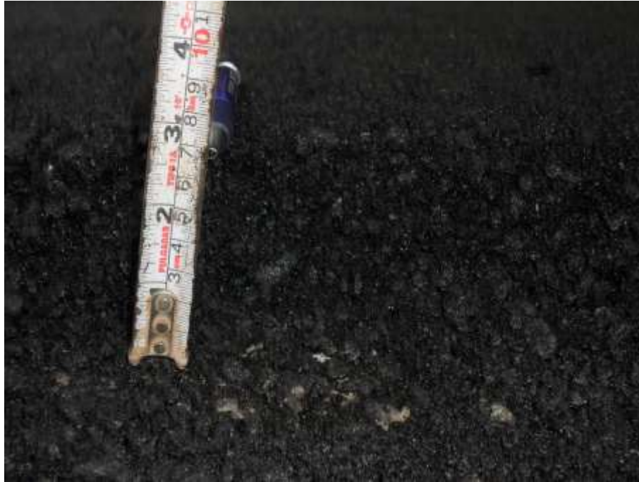
Fig. III 42 Espesor de la carpeta asfáltica.
