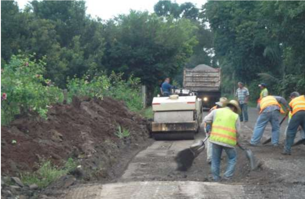
Fig. III. 30 Rodillo en compactación de sub-base al 95%.
