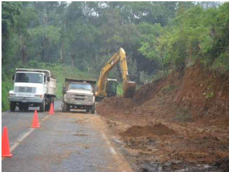
Fig. III. 5 Excavadora realizando segundo corte en tramo Huatusco-Conejos.
