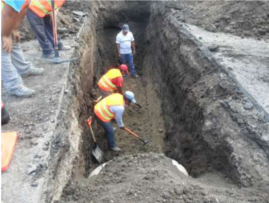
Fig. III. 19 Nivelación de base para colocación de tubería.
