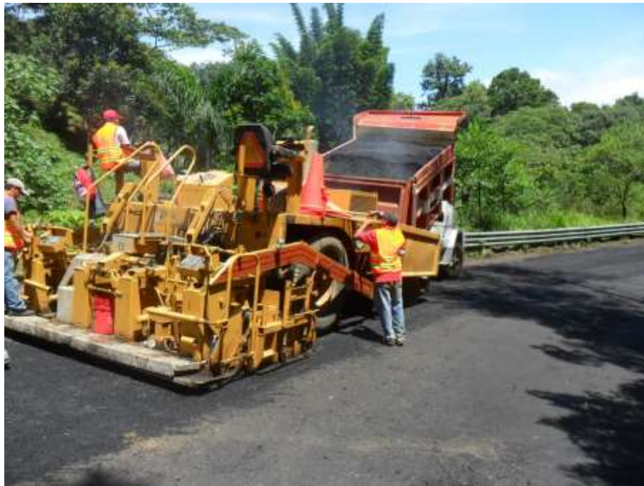
Fig. III 37 Pavimentadora afinando carpeta asfáltica.
