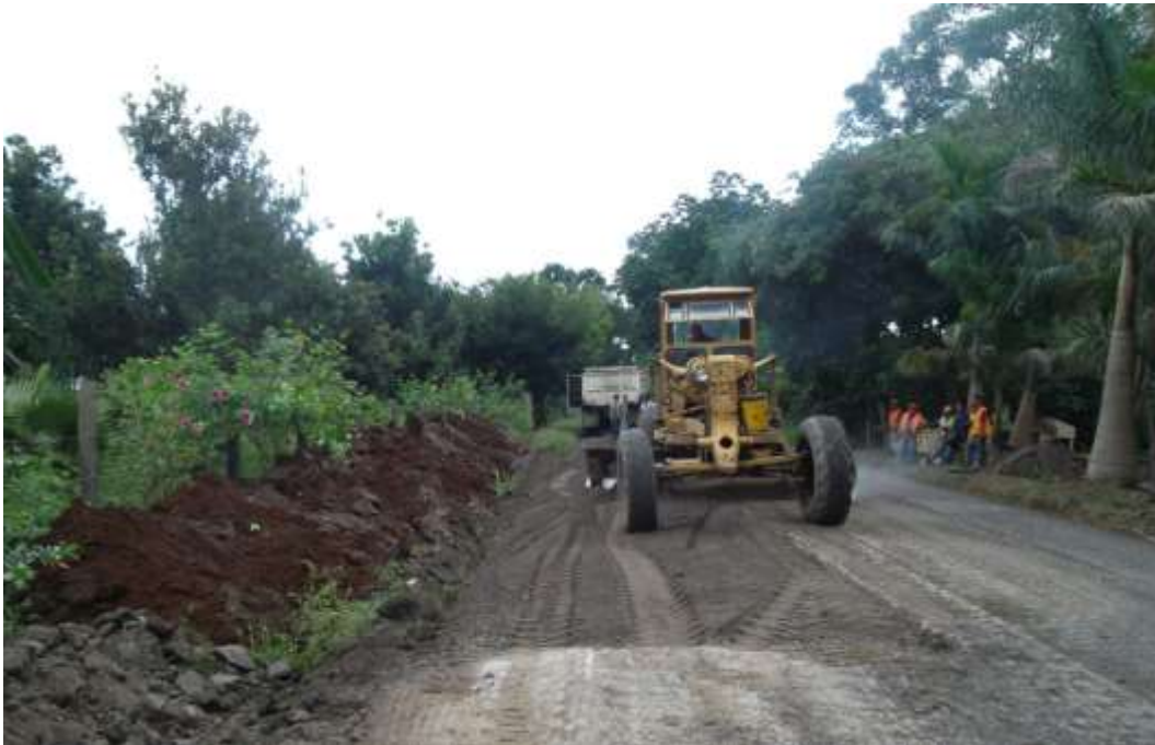
Fig. III. 31 Motoconformadora nivelando base.
