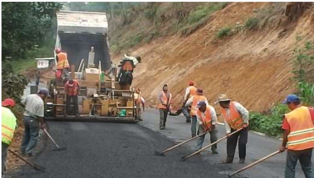
Fig. III 39 Pavimentación en zona de cortes.
