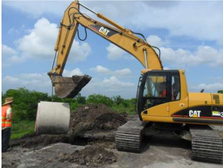
Fig. III. 14 Colocación de tubería de concreto reforzado, primera sección.
