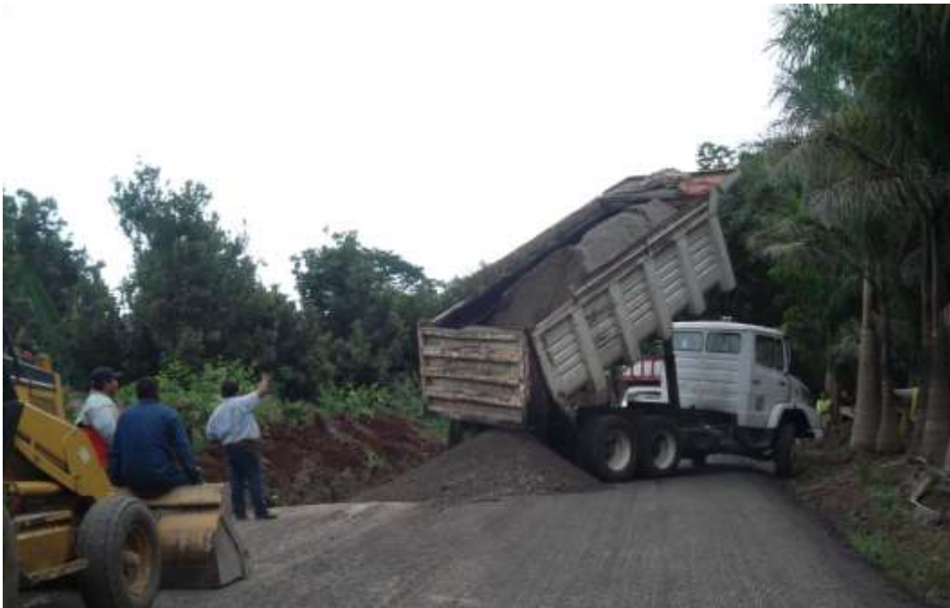
Fig. III. 29 Descarga de base.
