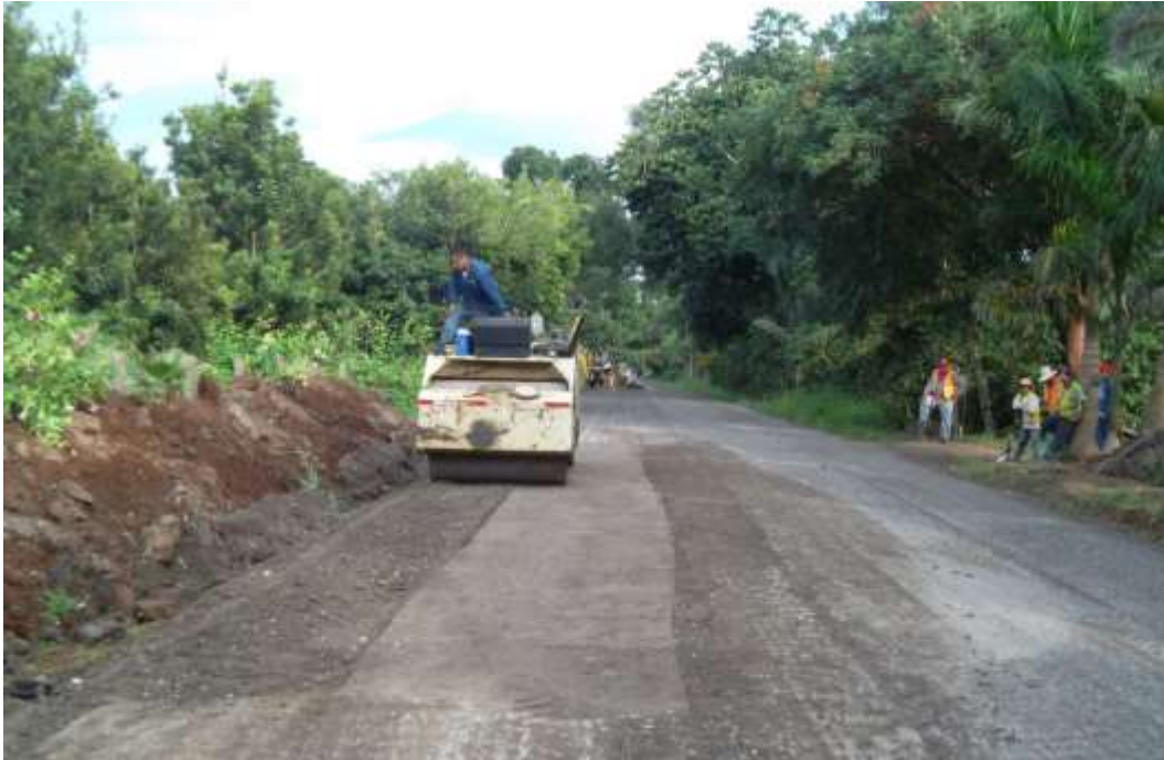
Fig. III. 32 Rodillo compactando la base.
