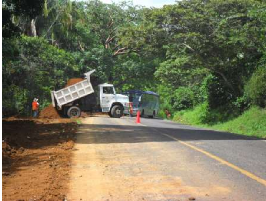
Fig. III. 6 Acarreo libre del segundo corte en tramo Huatusco-Conejos.
