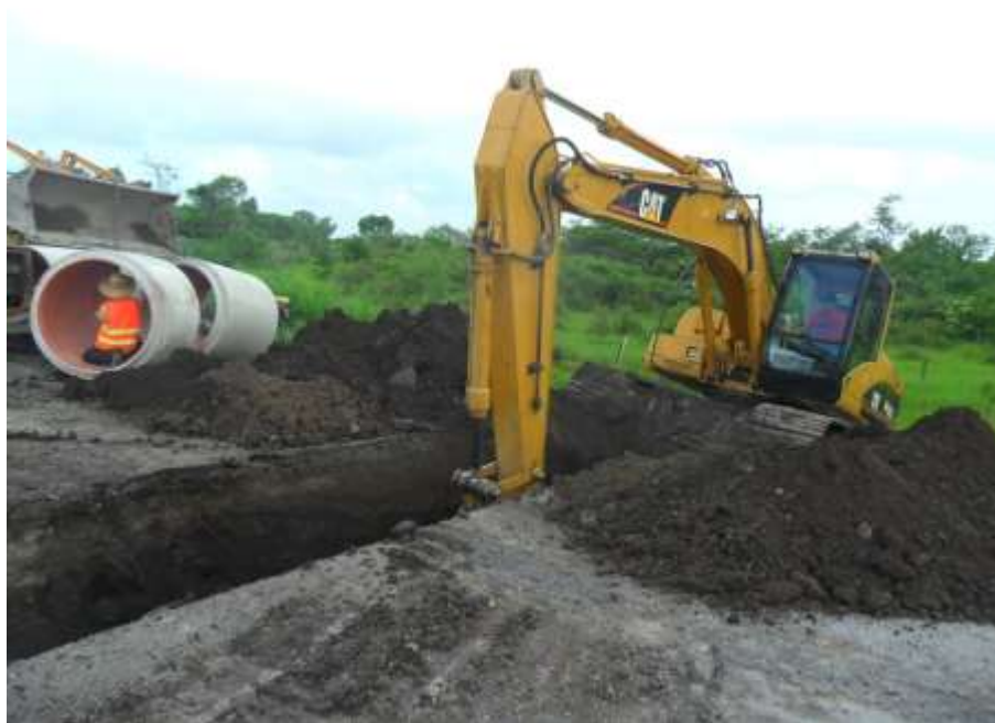
Fig. III. 18 Excavación para la colocación de tubería, segunda sección.
