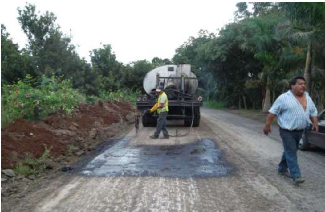
Fig. III 33 Impregnación en bacheo profundo.
