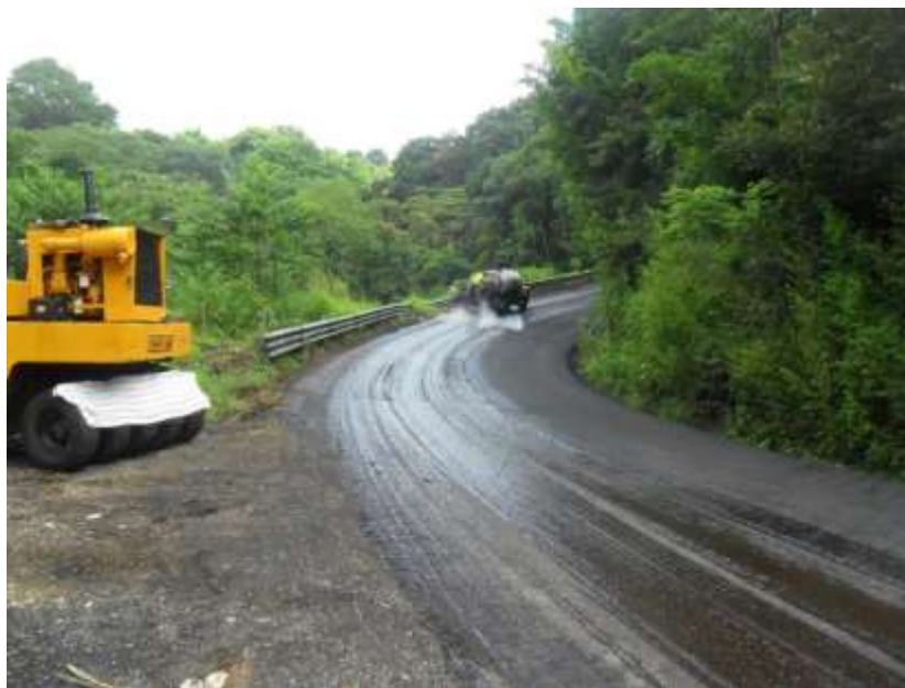
Fig. III 35 Inicio de tramo, riego de impregnación.
