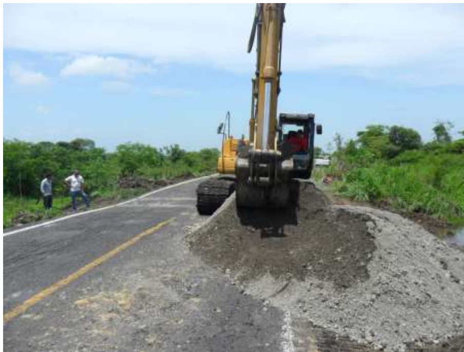
Fig. III. 11 Excavadora extendiendo la arena para eliminación de humedad.
