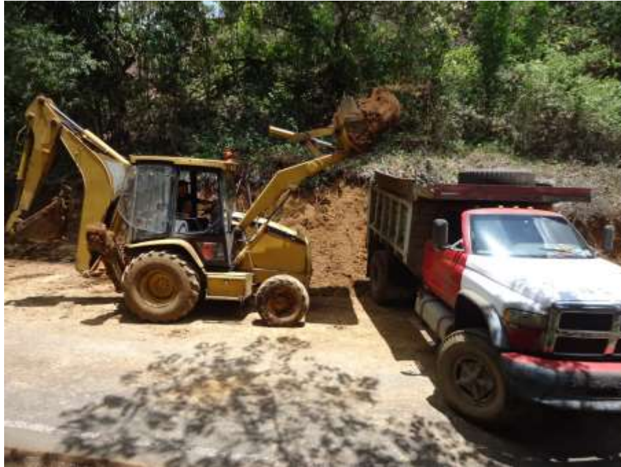
Fig. III. 2 Colocación de volúmenes de tierra del primer corte en tramo Huatusco-Conejos.
