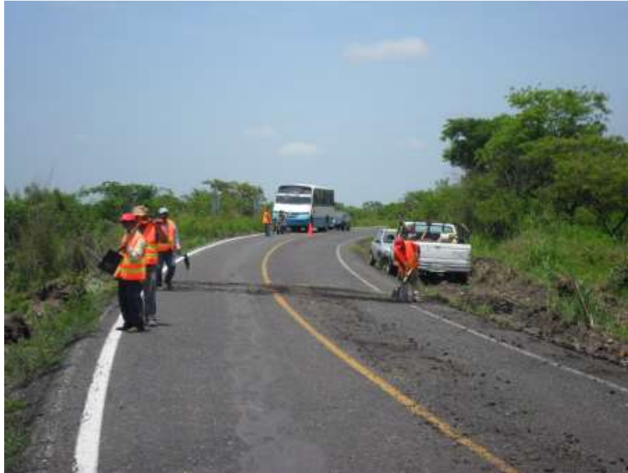
Fig. III. 10 Colocación de señalamientos en tramo para obras de drenaje.
