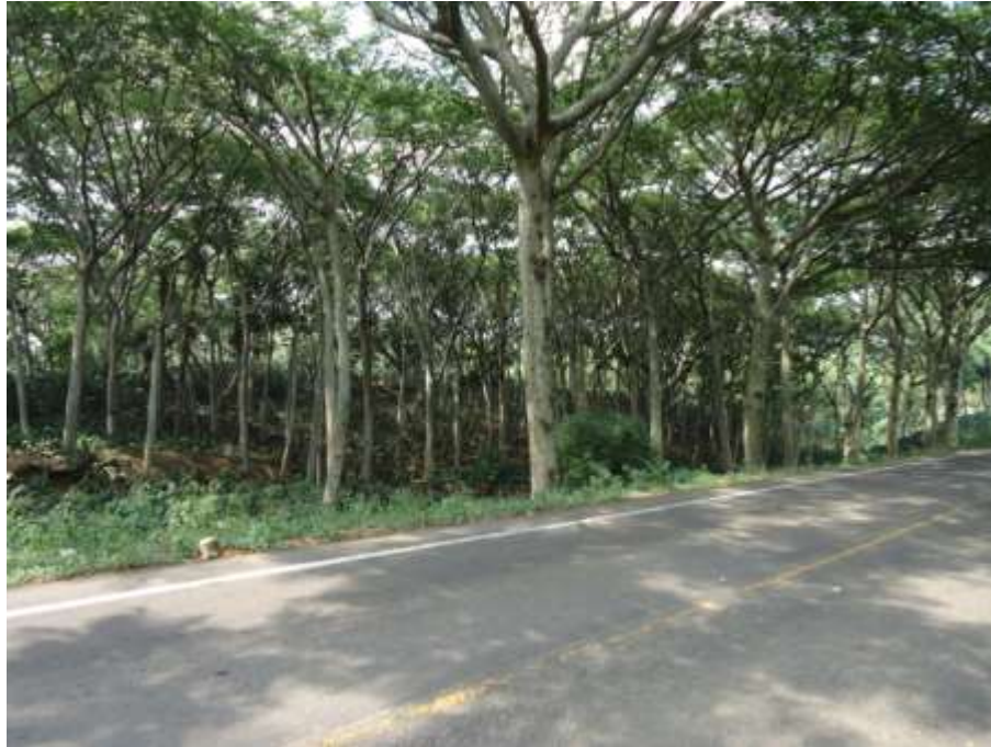
Fig. II. 2 Obsérvese el constante desgaste del pavimento y la presencia de fallas funcionales.
