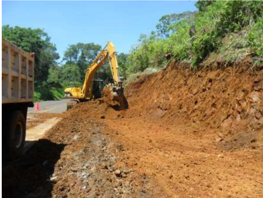
Fig. III. 8 Excavadora delimitando pendiente de talud y seccionando volúmenes de tierra para la base de gaviones.
