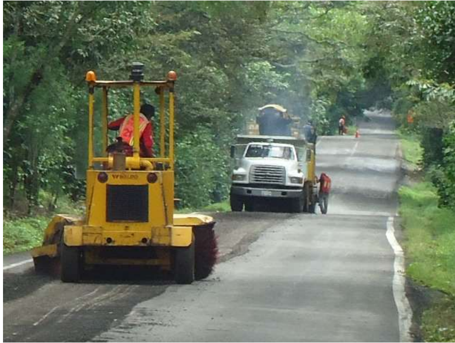
Fig. III. 23 Barredora dejando la superficie de rodadura libre de fresado.
