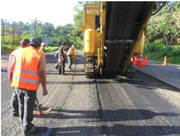
Fig. III. 22 Fresado de la superficie de rodadura.
