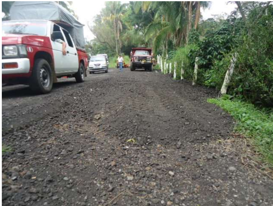
Fig. III. 24 Material de fresado, se reutilizo para entradas y estaciones de camiones rurales.
