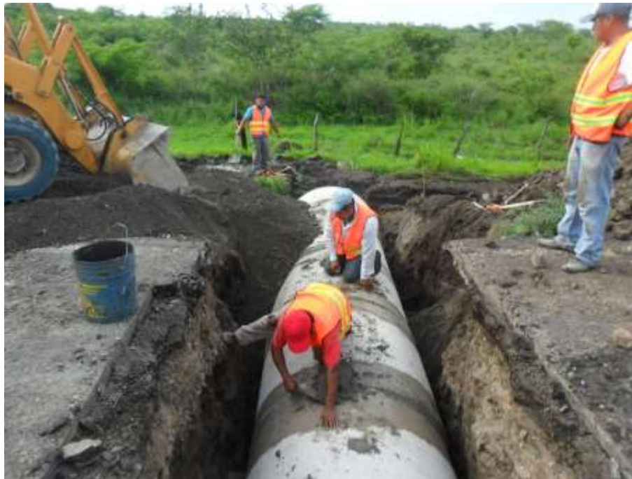
Fig. III. 15 Sellamiento de juntas con mortero cemento-arena.
