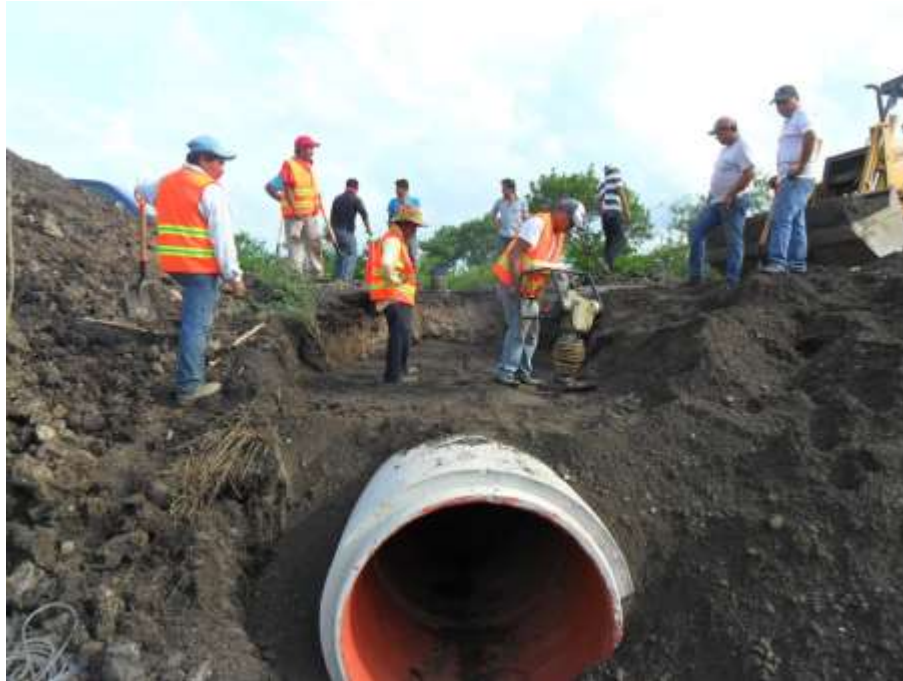
Fig. III. 17 Compactación de base en capas de 20 centímetros.
