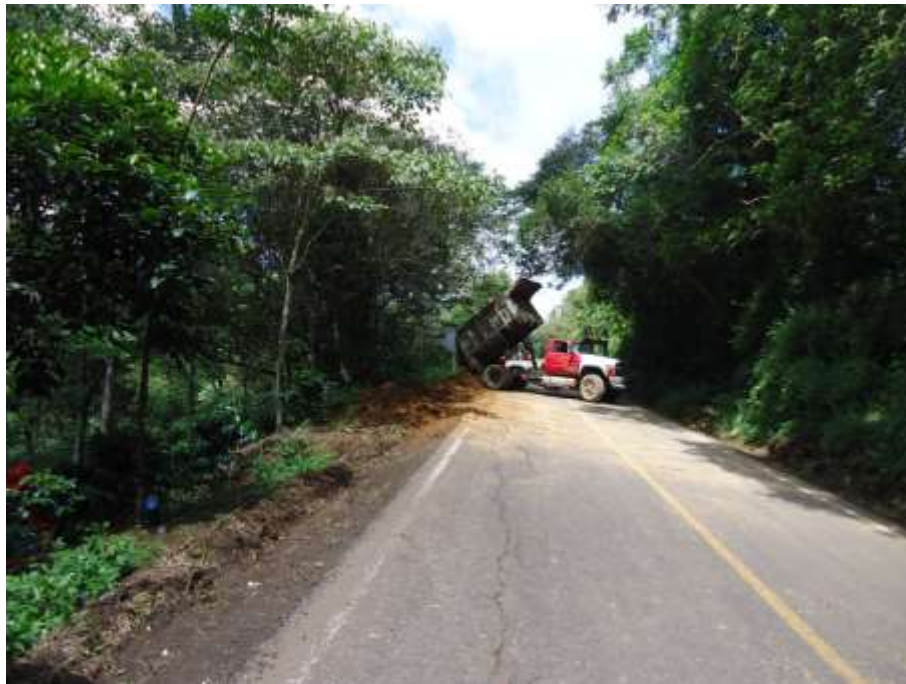
Fig. III. 3 Acarreo libre del primer corte en el tramo Huatusco-Conejos.
