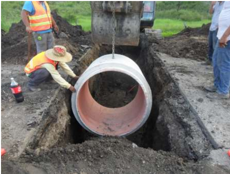
Fig. III. 20 Colocación de tubería de concreto reforzado, segunda sección.
