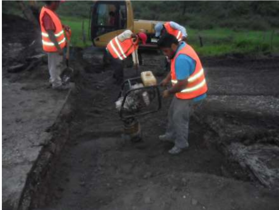
Fig. III. 21 Compactación de la base, segunda sección.
