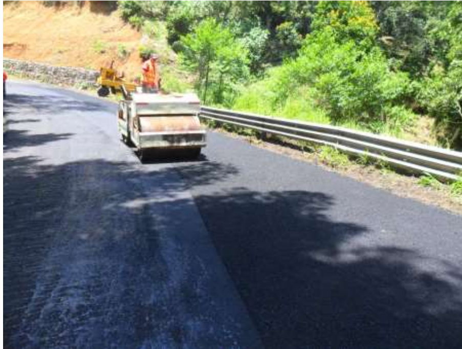
Fig. III 38 Compactación de carpeta con rodillo compactador de doble tambor.
