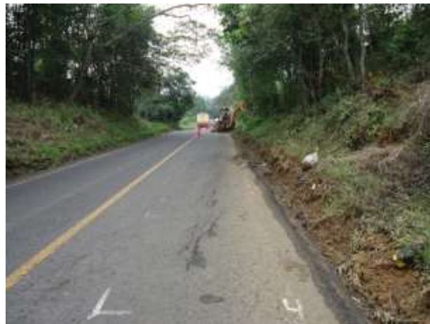
Fig. III. 1 Limpieza de cunetas con retroexcavadora para ejecución del primer corte en el tramo Huatusco-Conejos.
