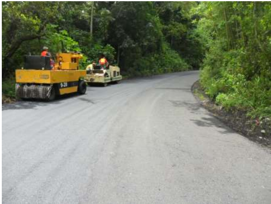
Fig. III 41 Terminación de carpeta asfáltica.
