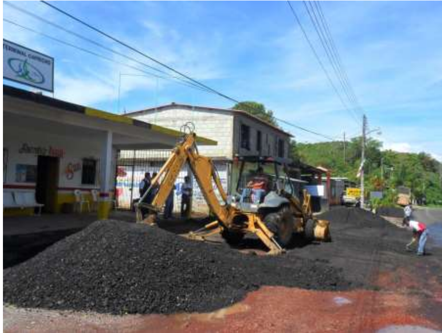
Fig. III. 25 Material de fresado, se reutilizo para estaciones de camiones rurales.
