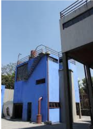
Juan O´Gorman, Escaleras, Casa habitación Frida Kahlo, detalle.
