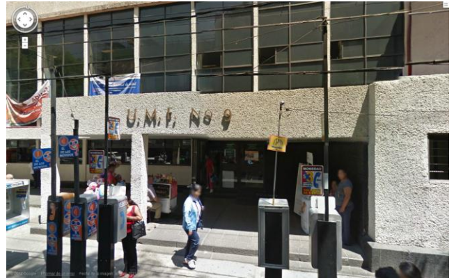
Fachada Sur de la unidad vista desde la calle 7.
