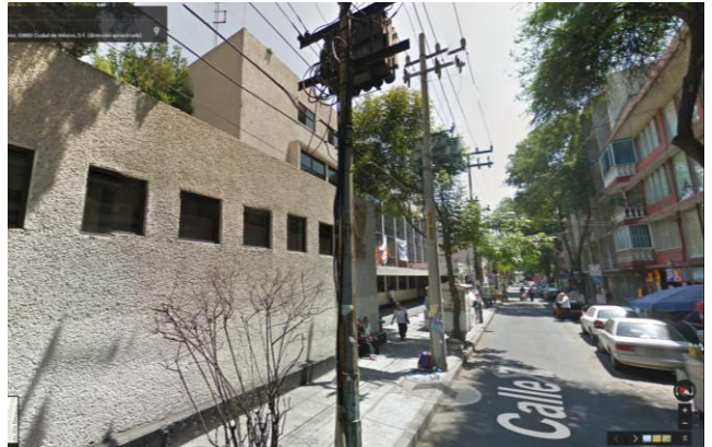
Fachada Sur de la unidad vista desde la calle 7.
