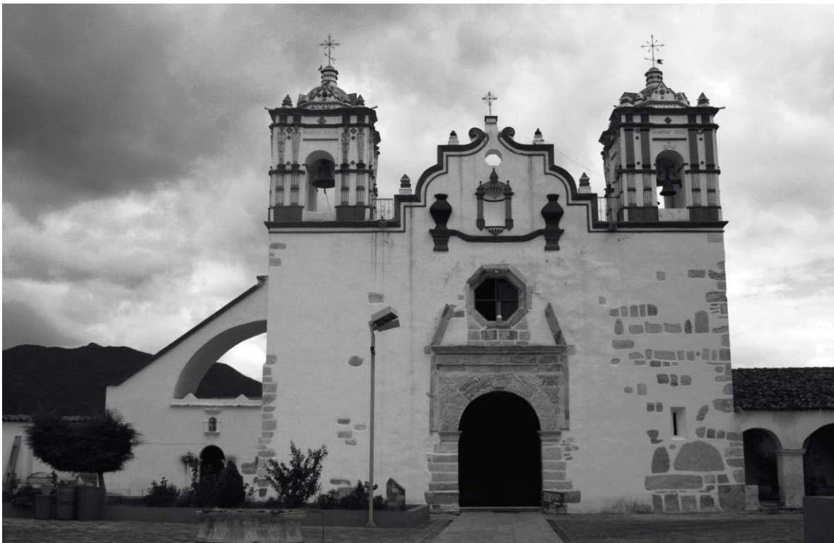
Figura 2. Iglesia de Teotitlán del Valle. En ella se aprecian bloques de piedra con grabados prehispánicos, los cuales fueron colocados por los habitantes del pueblo en distintos lugares del edificio.
