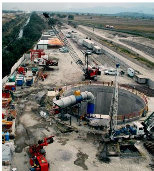
Figura 3.9. Lumbrera del Túnel Emisor Oriente.
