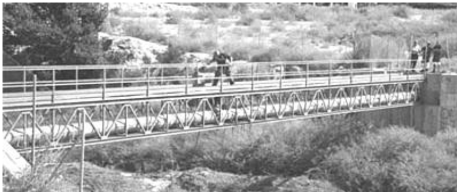
Figura 2.14 Cruce elevado en el río Vinalopó, España.
