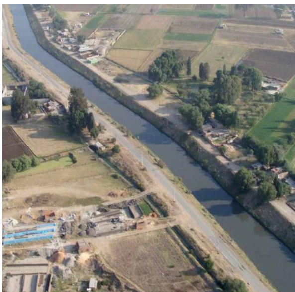
Figura 3.6. Vista aérea del gran canal de desagüe.
