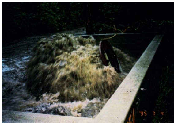
Figura 1.2. Voladura de la tapa de un pozo de visita del drenaje en la Ciudad de Edmonton, Canadá.
