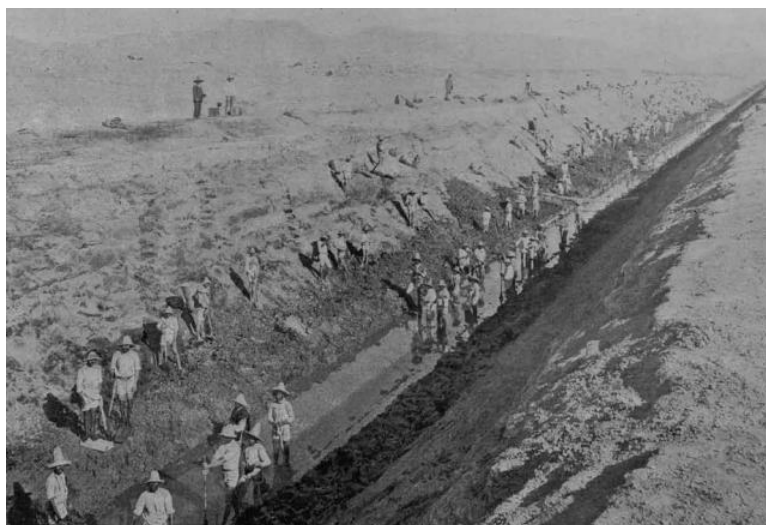
Figura 3.4. Construcción del gran canal de desagüe de la Ciudad de México, Km 7.
