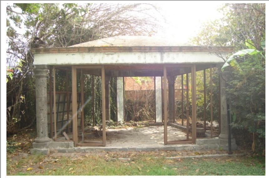
Como anteriormente se menciona, la capilla necesitará una remodelación total, pero como se ve en las imágenes su estructura está en buen estado, incluso se puede apreciar que las columnas tienen en perfecto estado su acabado exterior.
